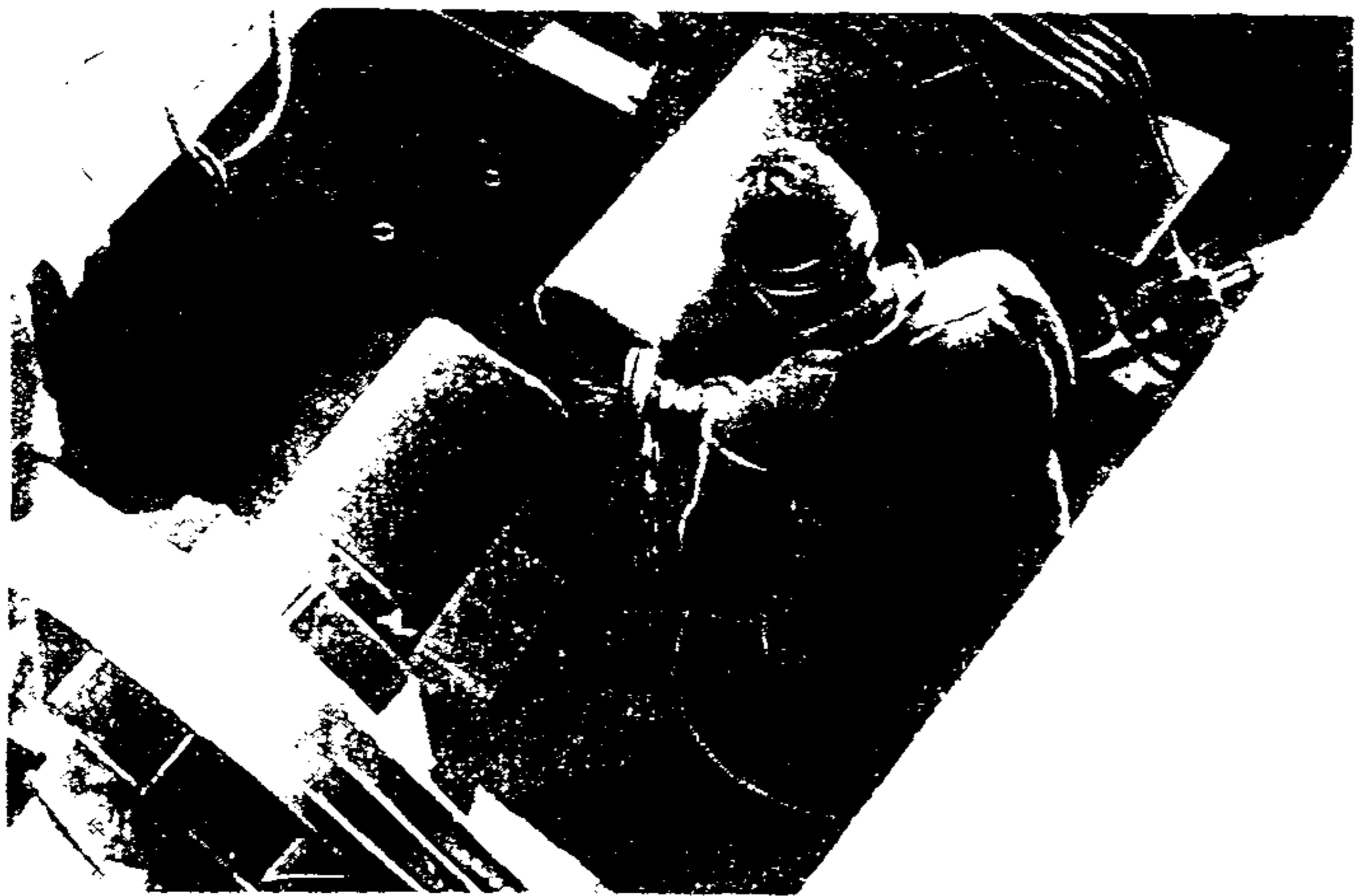
Рис.15. Подготовка торца трубы к сварке
