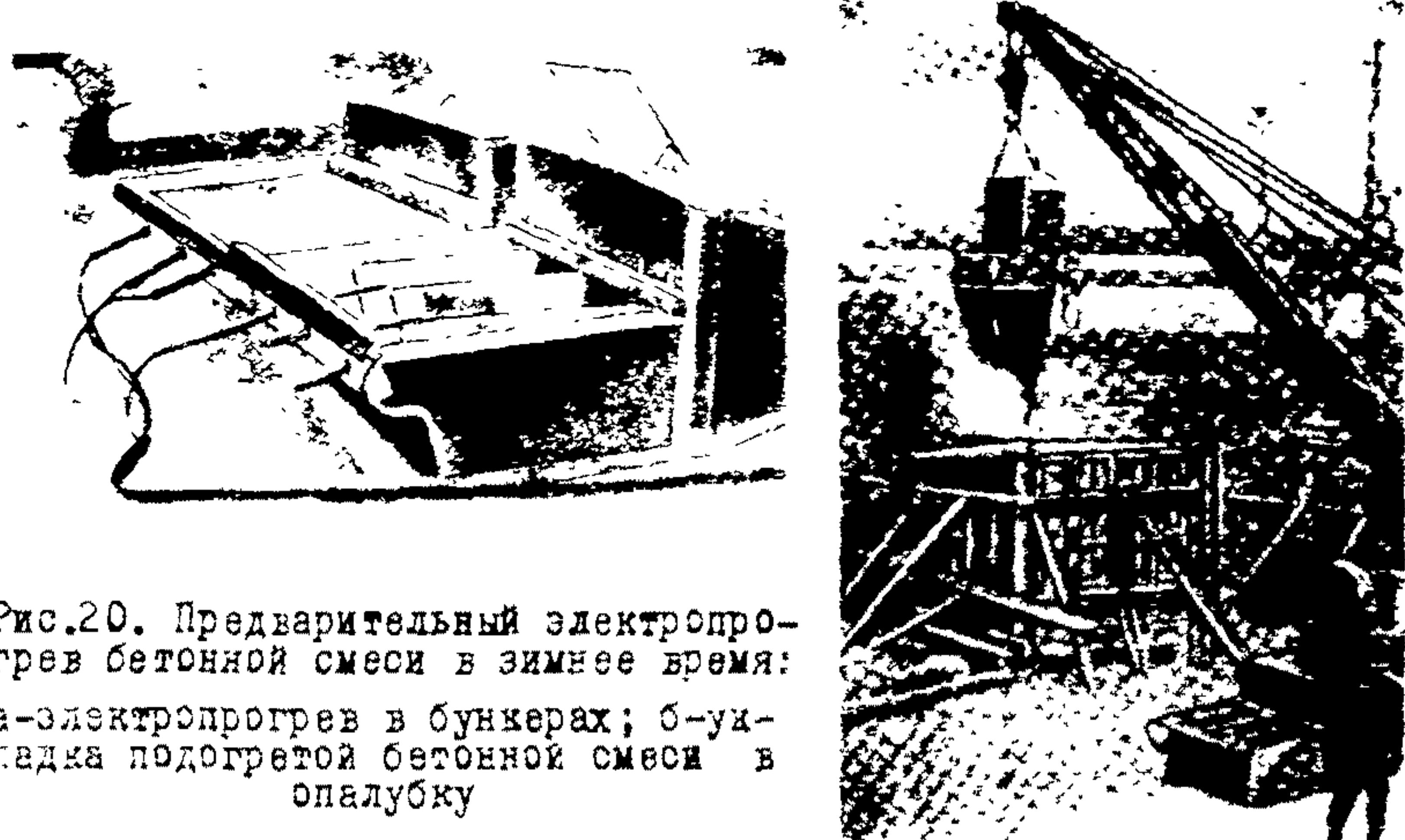
Рис.20. Предварительный электропрогрев бетонной смеси в зимнее время:
