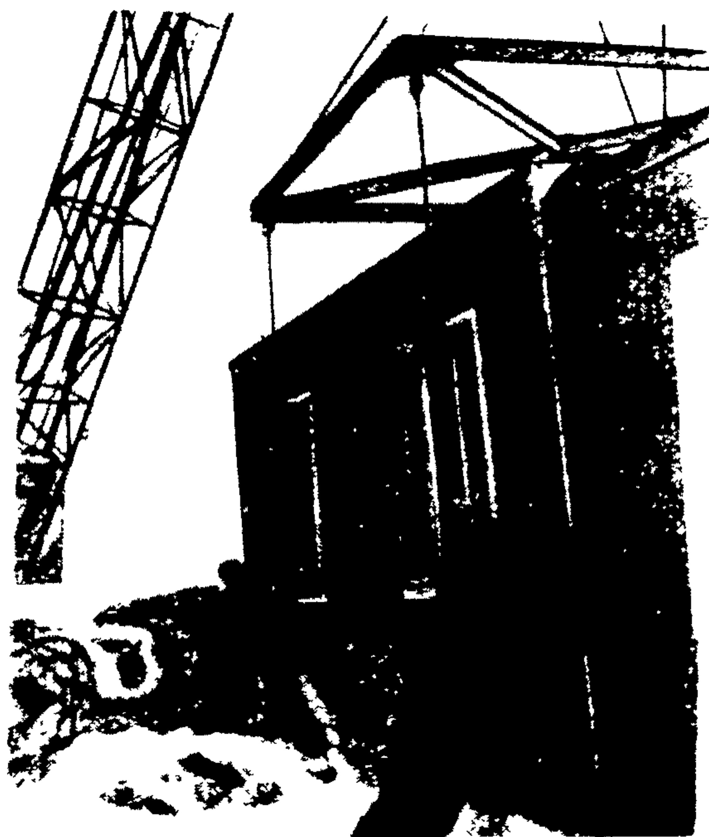
Рис. I8. Применение специальной траверсы для монтажа контейнерных зданий
