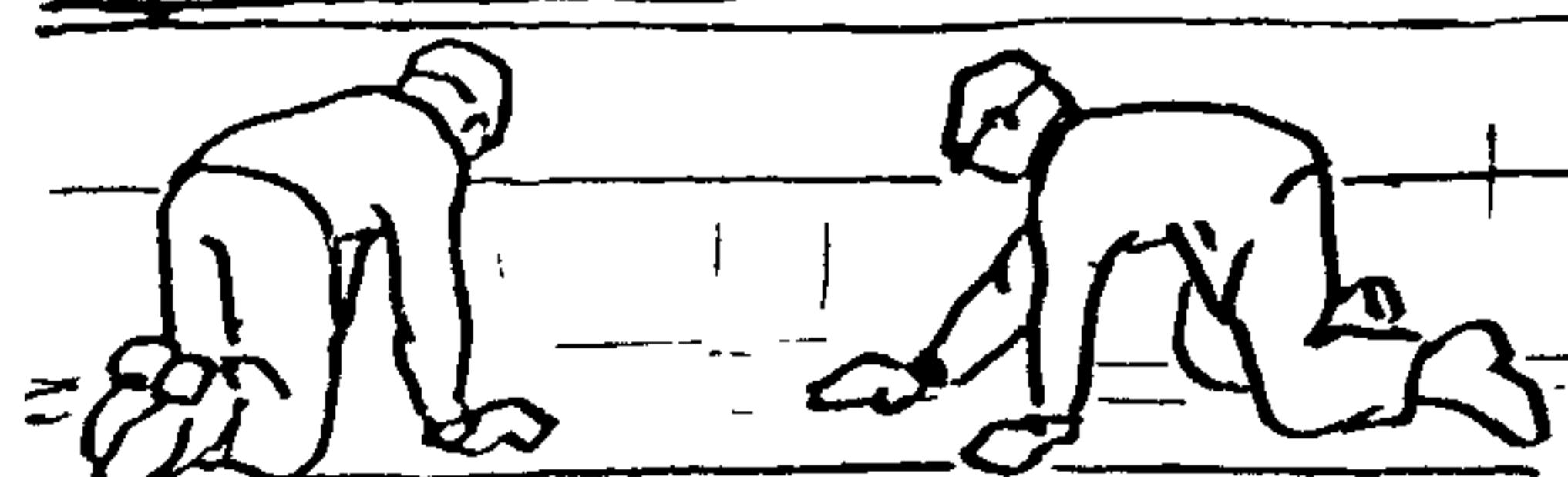
Затем полотнище отгибают и тщательно прижимают к основанию по закруглению и основной плоскости
