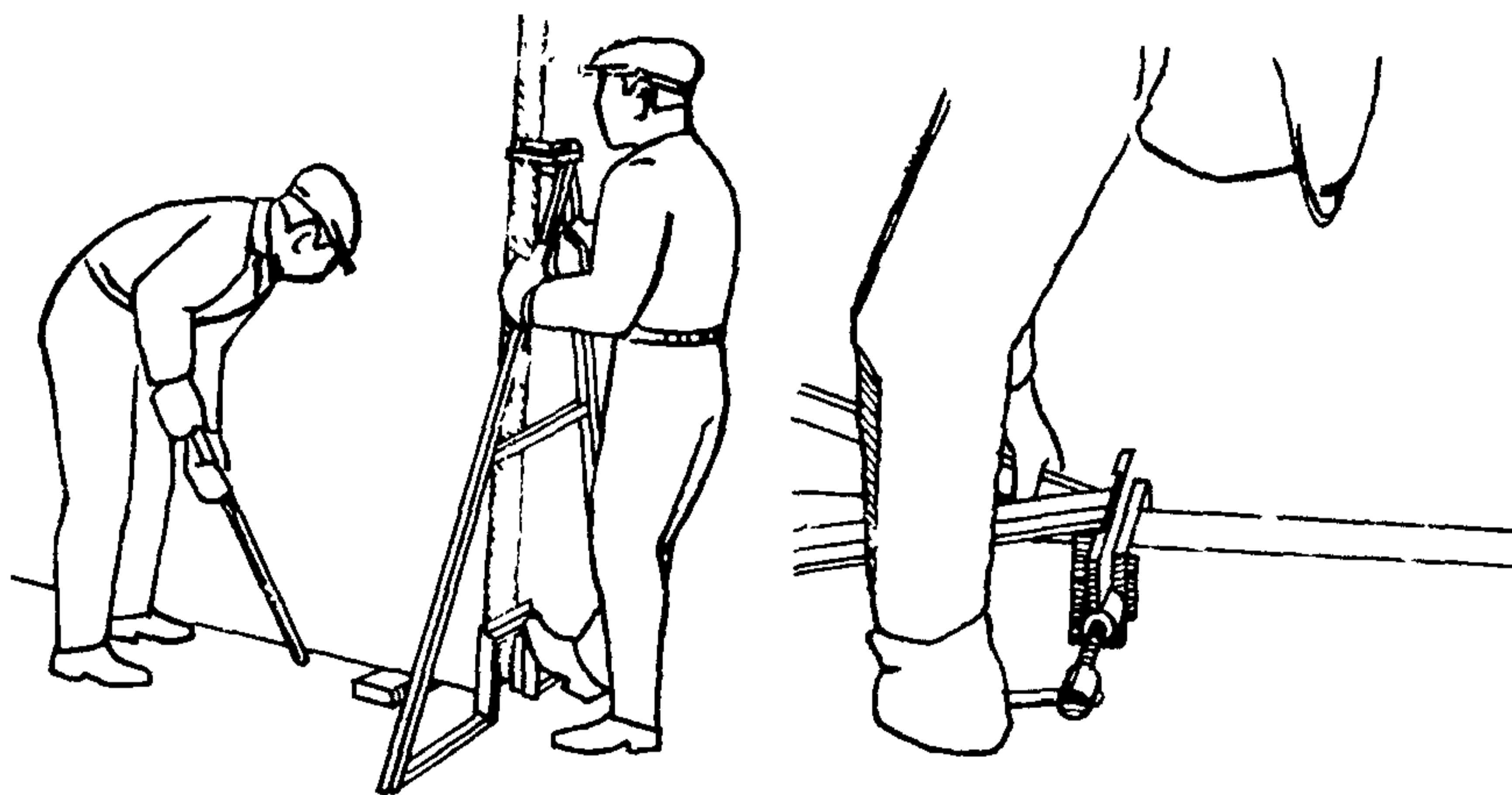
Монтажники  $M_1$  и  $M_2$  принимают по данную краном панель, направляют ее к месту установки и устанавливают на подкладки по сделанной разметке. Затем монтажник  $M_1$  подносит инвентарную стойку к торцу панели и устанавливают так, чтобы панель торцом вошла в ее вилку.
