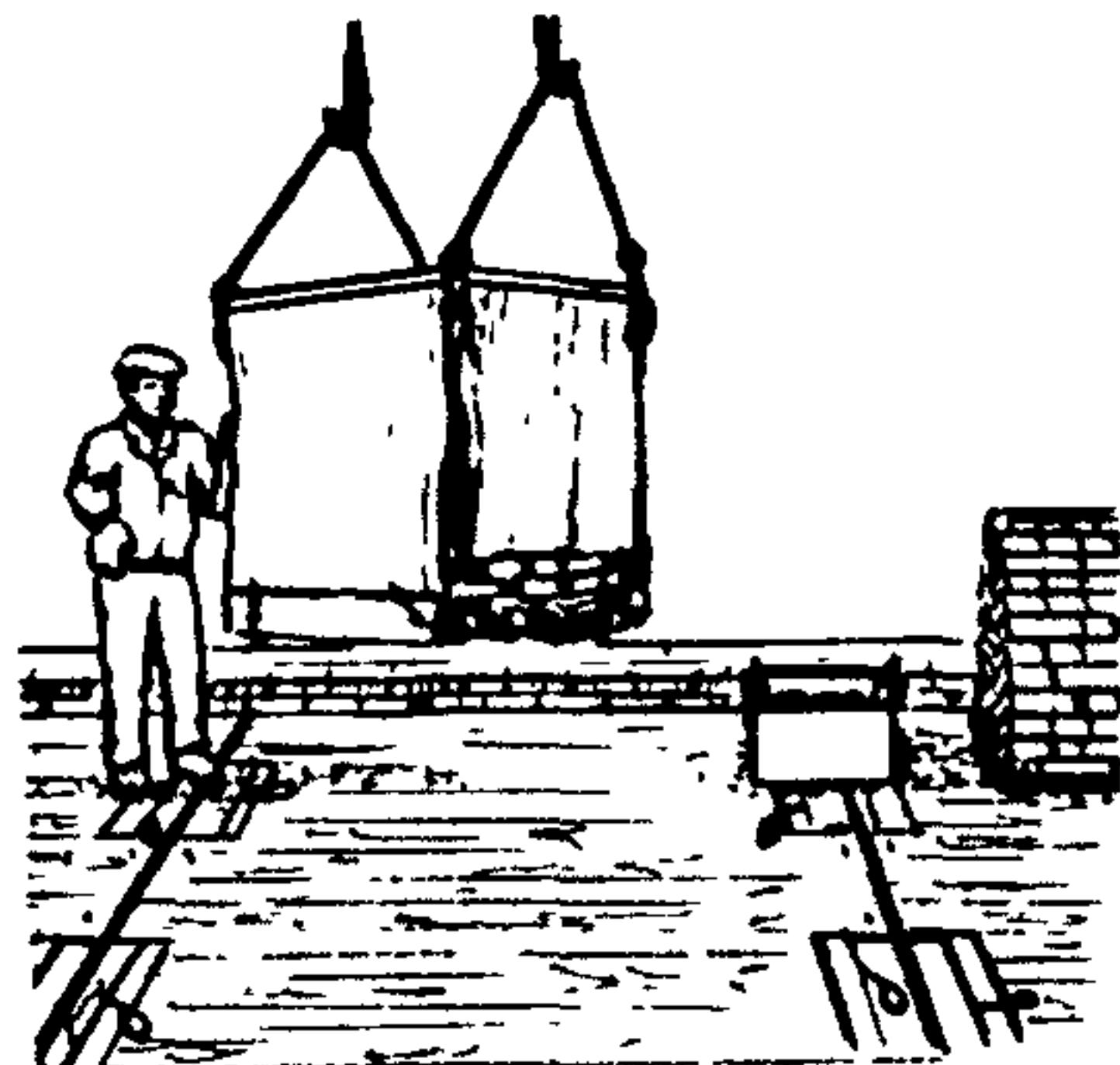
По сигналу такелажника  $T_1$  машинист башенного крана поднимает и перемещает поддоны с кирпичом. Такелажник  $T_3$  следит за перемещением поддонов, принимает и устанавливает их на подготовленное место
