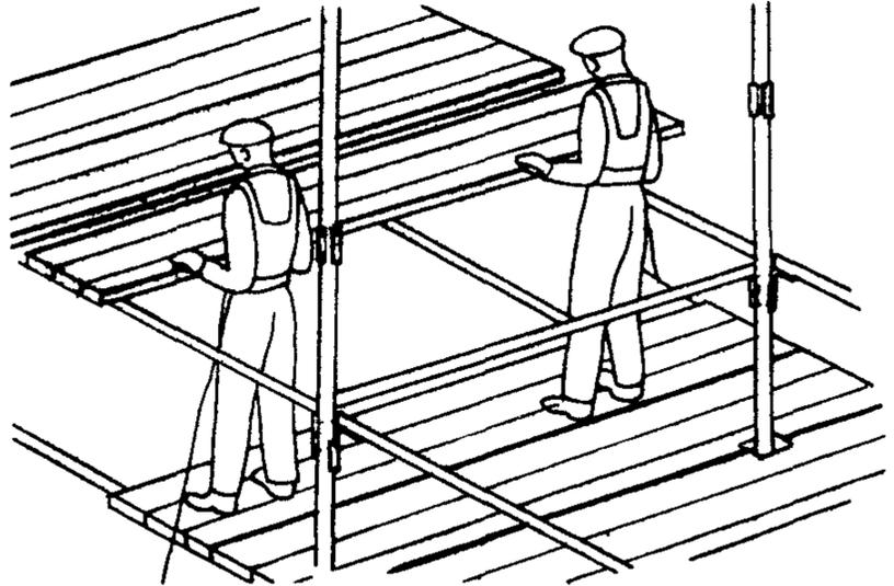
6 УСТАНОВКА ЭЛЕМЕНТОВ ОГРАЖДЕНИЯ НА ТРЕТЬЕМ ЯРУСЕ;  $M_1$  - 5 мин;  $M_2$  - 2,5 мин; молоток
