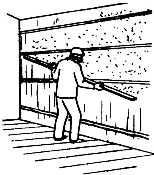
Штукатур Ш<sub>1</sub> с помощью правила разравнивает грунт по маякам до получения ровной поверхности. Штукатур Ш<sub>2</sub> полутерком разравнивает грунт в труднодоступных местах, а затем контрольным правилом проверяет ровность поверхности
