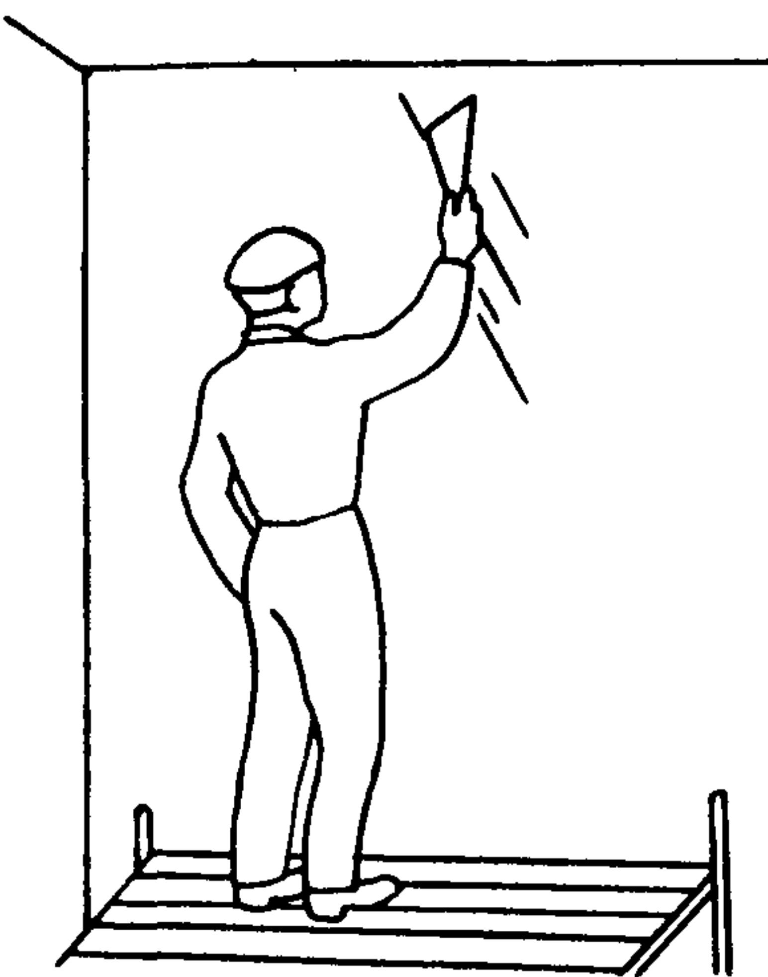
Маляры  $M_1$  и  $M_2$  (один с пола, другой со столика-подмостей) скребками на удлиненных ручках очищают поверхность стен от затвердевших брызг раствора. Затем лещадью, закрепленной в обойме, удаляют следы грубой затирки и другие шероховатости. Трешины глубиной до 2 мм расшивают шпателем, держа его под углом  $45^\circ$  к поверхности стены
