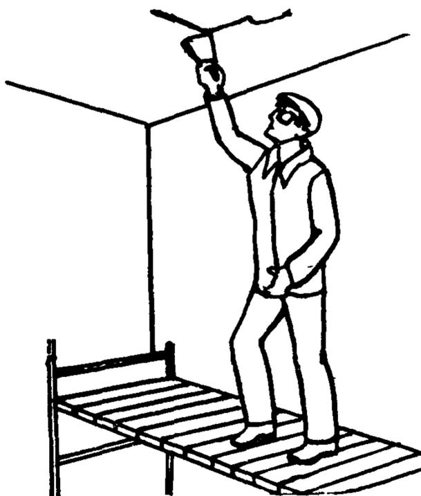
Маляры  $M_1$  и  $M_2$ , стоя на столиках-подмостях, углами шпателей расширяют трещины на глубину около 2 мм. Шпатели они держат под углом  $45^\circ$  к потолку
