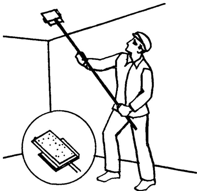
Маляры  $M_1$  и  $M_2$ , стоя на полу, шарнирными терками шлифуют прошпаклеванную поверхность
