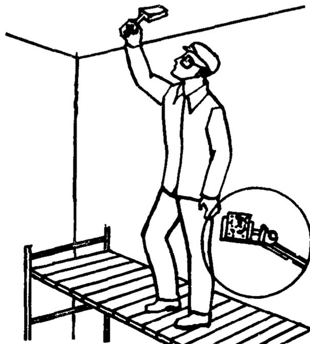
3 РАСШИВКА ТРЕЩИН; 12 мин;  $M_1, M_2$ ; шпатели, столики-подмости
