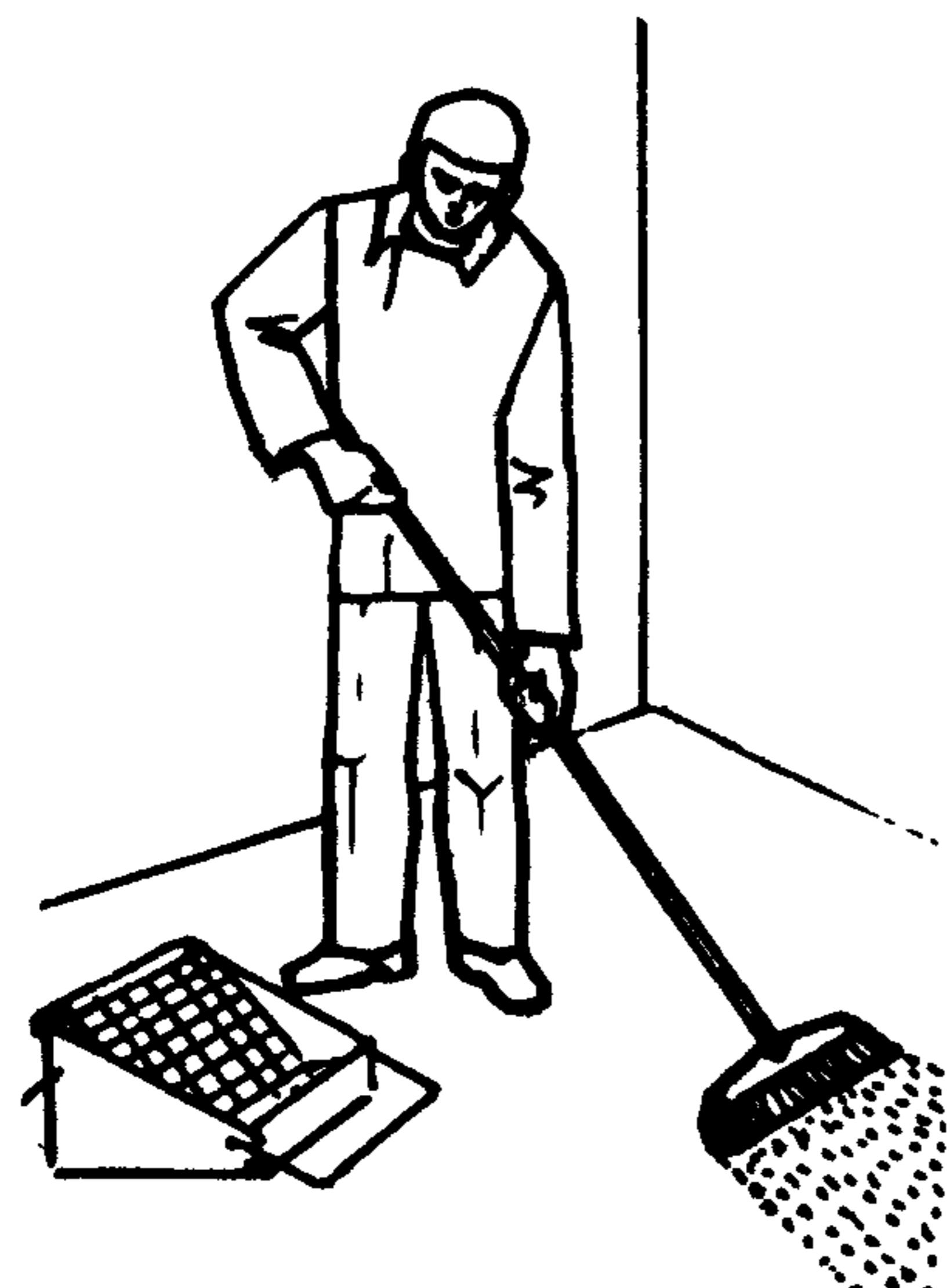
Паркетчики погружают щетки в ванночки с составом и отжимают излишки состава о сетки. Движениями щеток вперед и назад они наносят огрунтовку на поверхность основания сплошным ровным слоем, не допуская пропусков и образования луж
