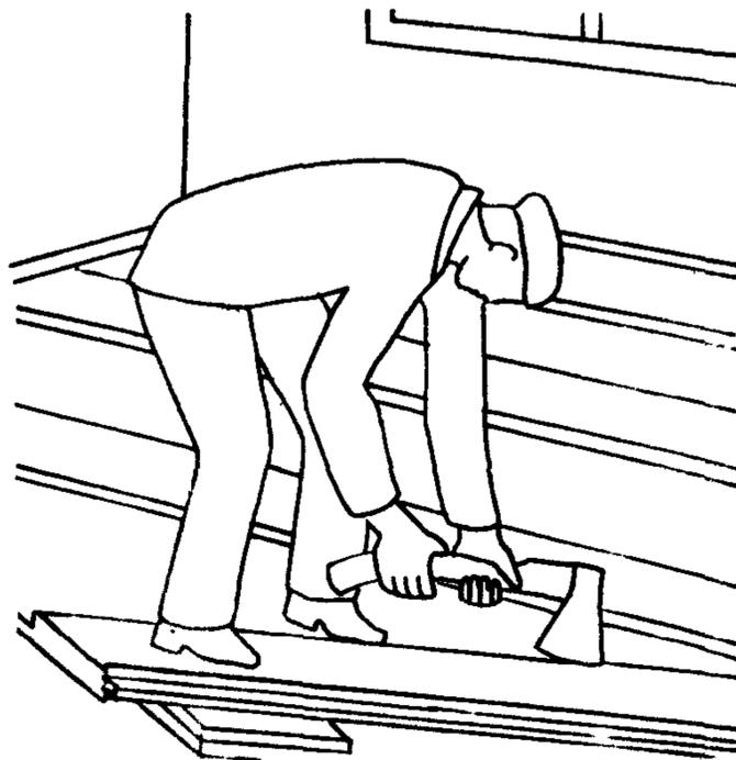
Плотники П<sub>1</sub> и П<sub>2</sub> выбирают четверть в кромке доски со стороны шпунта и в торцах, размечают и зашлифовывают концы доски на ус для сопряжения в углах.
