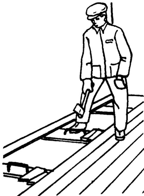
Плотники П<sub>1</sub> и П<sub>2</sub>, проверив правильность настилки рядовых досок, прибивают их гвоздями, втапливая шляпки добойником
