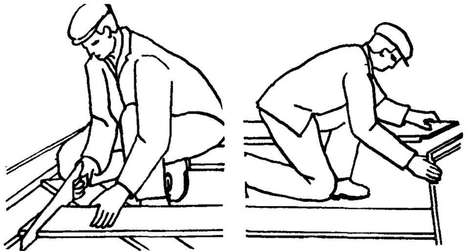
Плотники П<sub>1</sub> и П<sub>2</sub>, уложив на лаги и пригнав фризových доски в углах на ус согласно сделанной заготовке, прибивают их гвоздями
