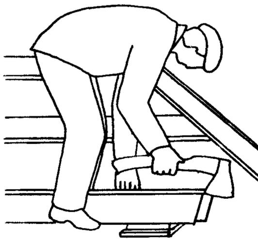
Плотники П<sub>1</sub> и П<sub>2</sub> выбирают четверть в торцах рядовых досок для соединения с фризowymi досками.
