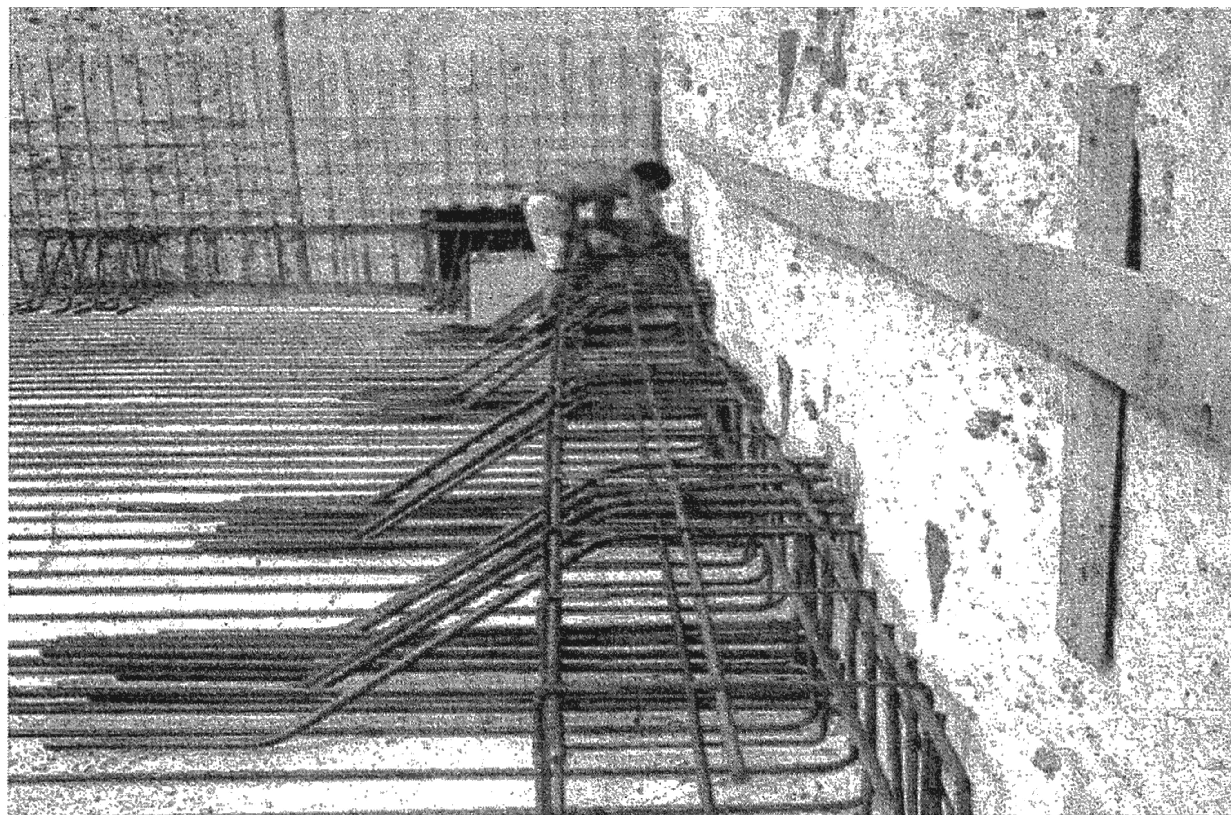
**2 Наращивание парапета и устройство балконных плит**
