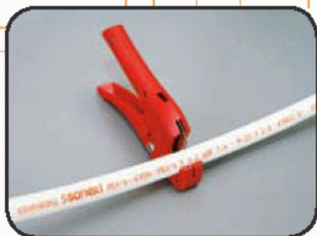
Отрезать трубу SANEXT PEX\\EVON\\PEX под прямым углом ножницами, предназначенными для резки труб.
