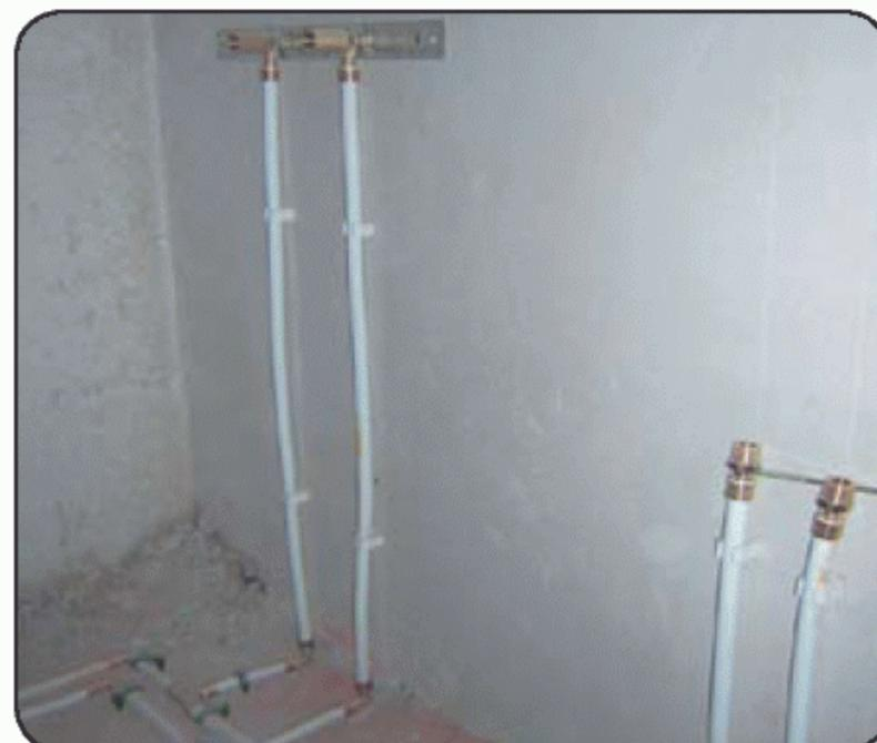
мости (например, при обнаружении протечек или проведении ремонта в помещении) любой из лучей системы можно отключить, а дефекты можно быстро обнаружить и устранить.
