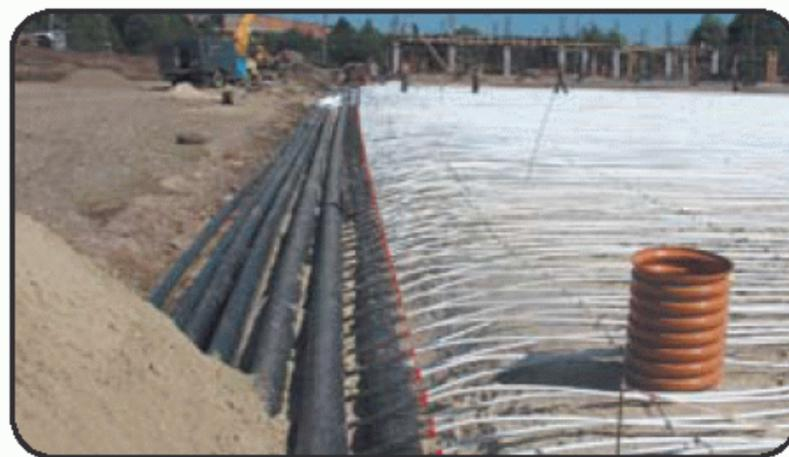
Обязательным условием нормальной работы систем поверхностного обогрева и охлаждения, смонтированных под открытым небом, является наличие правильно установленного дренажа поверхности.
