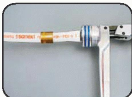
Вставить в трубу расширитель с головкой требуемого диаметра до упора. Равномерно свести рукоятки расширителя за два цикла (труба при этом проворачивается вокруг своей оси на 30°).
