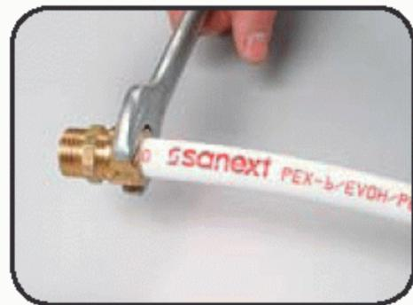
Закрутить обжимную гайку при помощи гаечного ключа. Соединение фитинга и трубы SANEXT PEX//EVOH//PEX готово.
