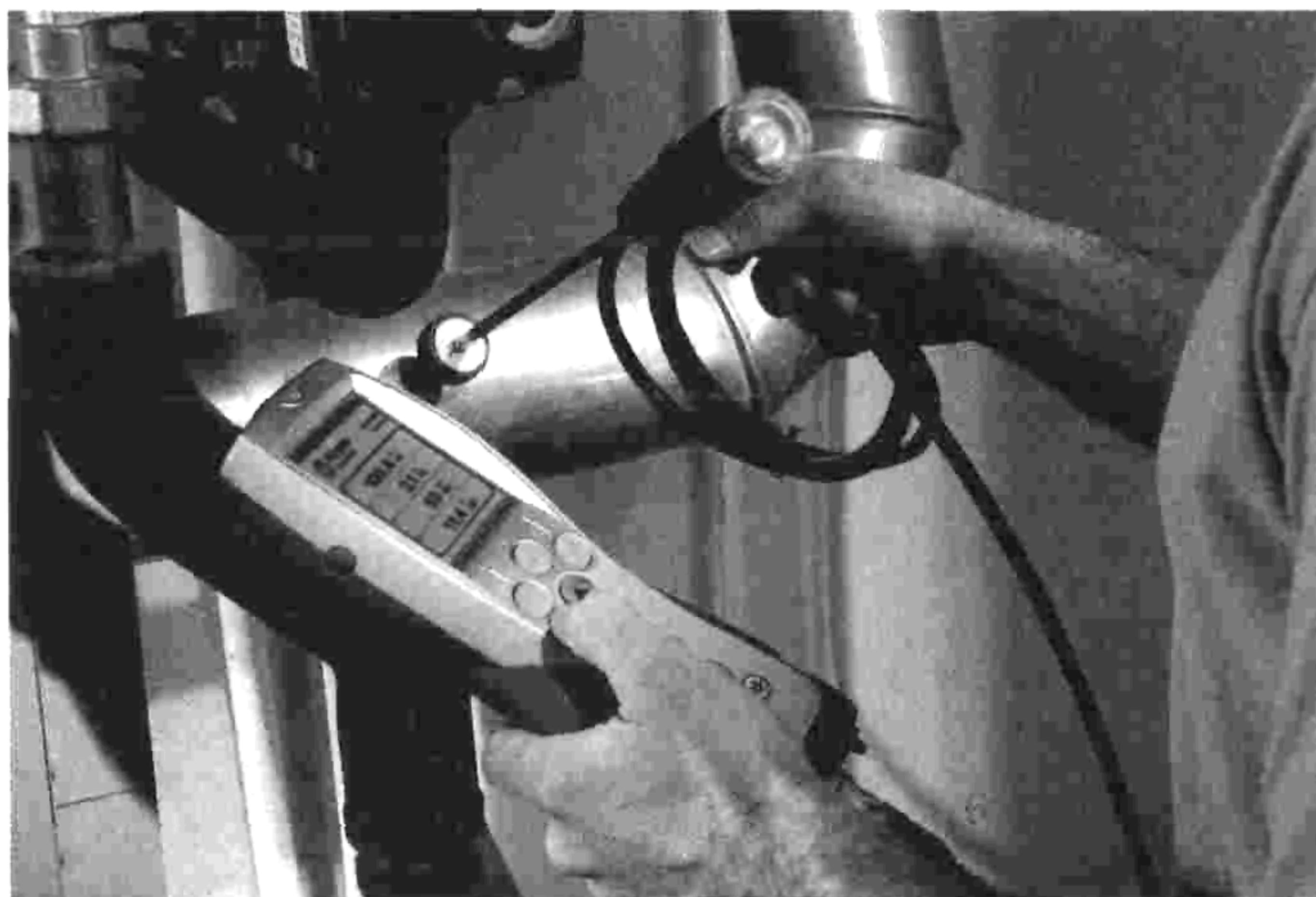
Рис. 13: Определение потери тепла с дымовыми газами
