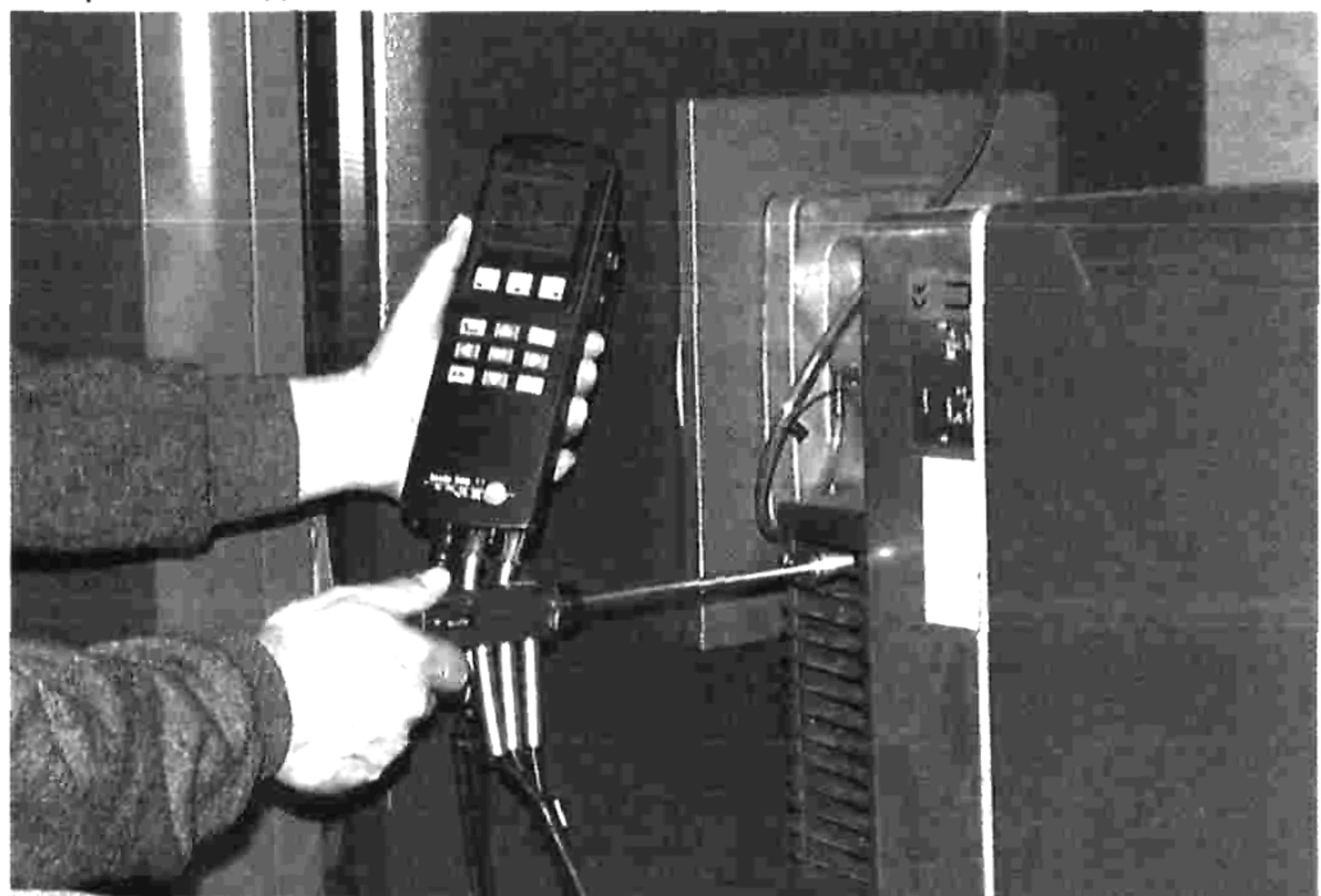
Рис. 12: Измерение температуры воздуха подающегося на горение
