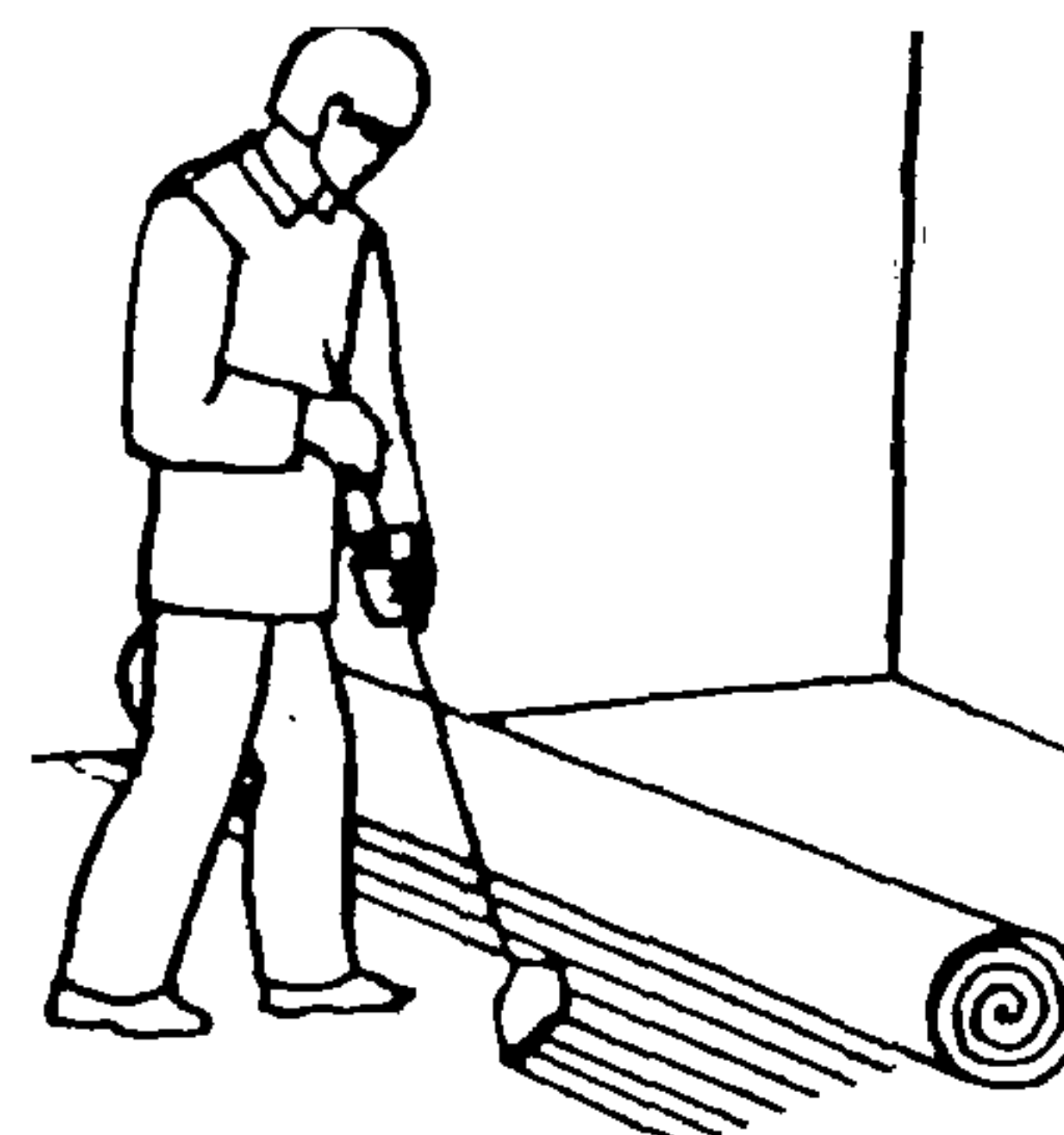
Рисунок 9 – Разравнивание клея гребенкой
