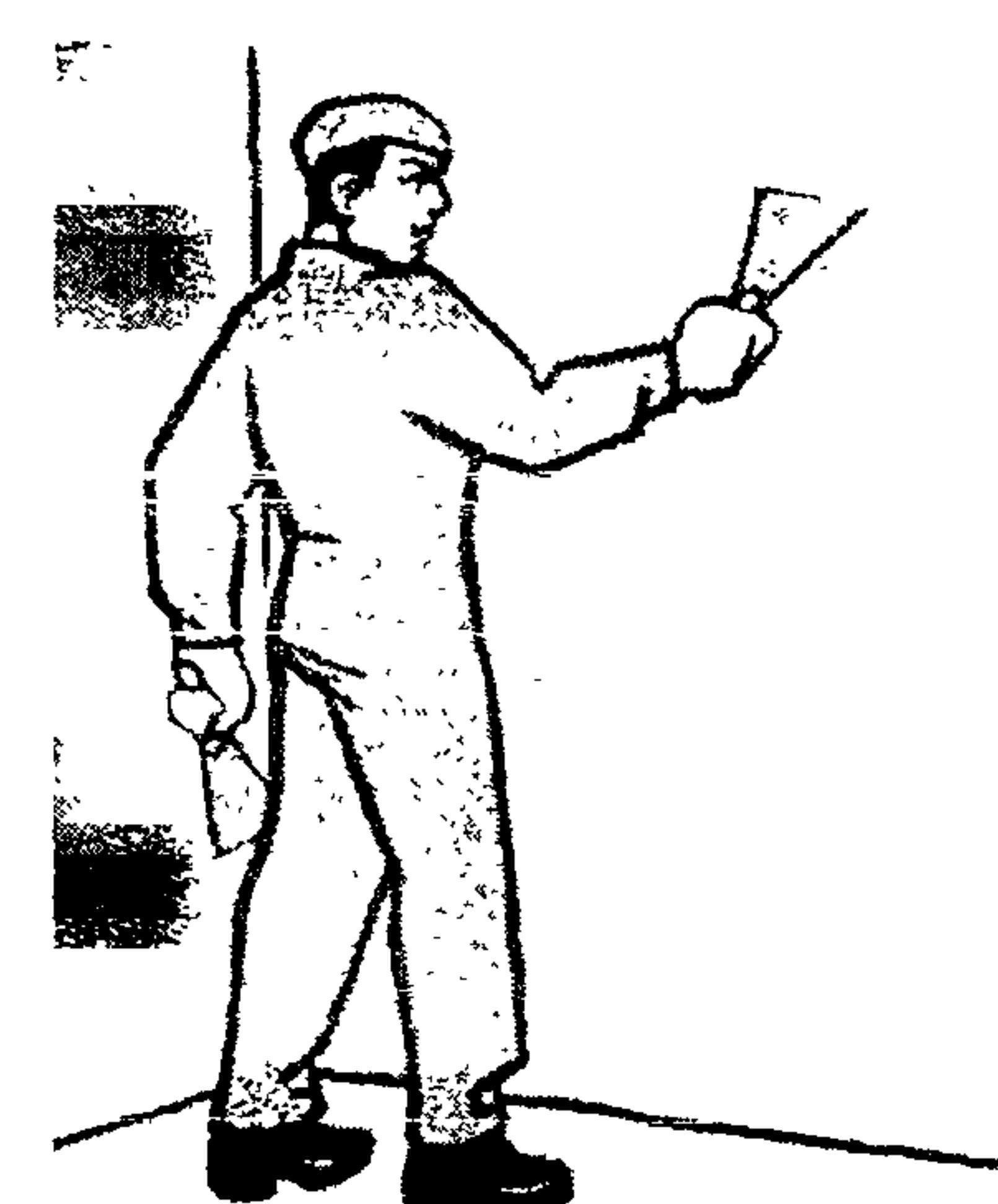
Рисунок 4 – Заполнение шпатлевкой трещин
