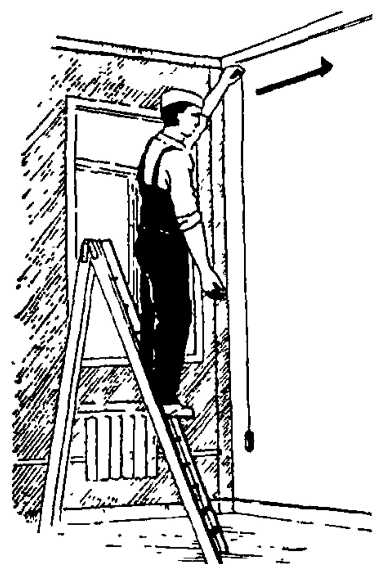
Рисунок 14 – Провешивание
