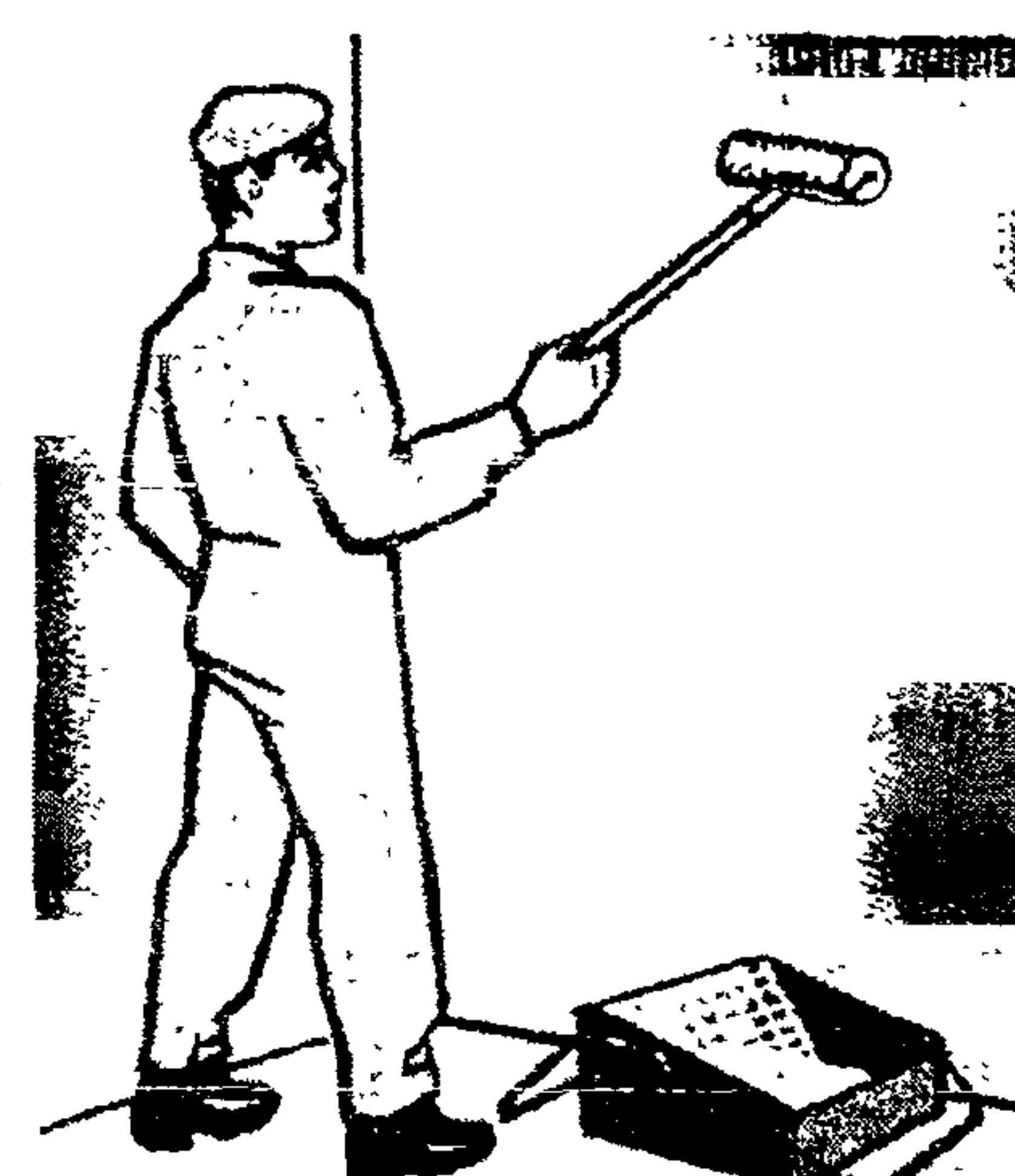
Рисунок 3 – Нанесение грунтовки на поверхность
