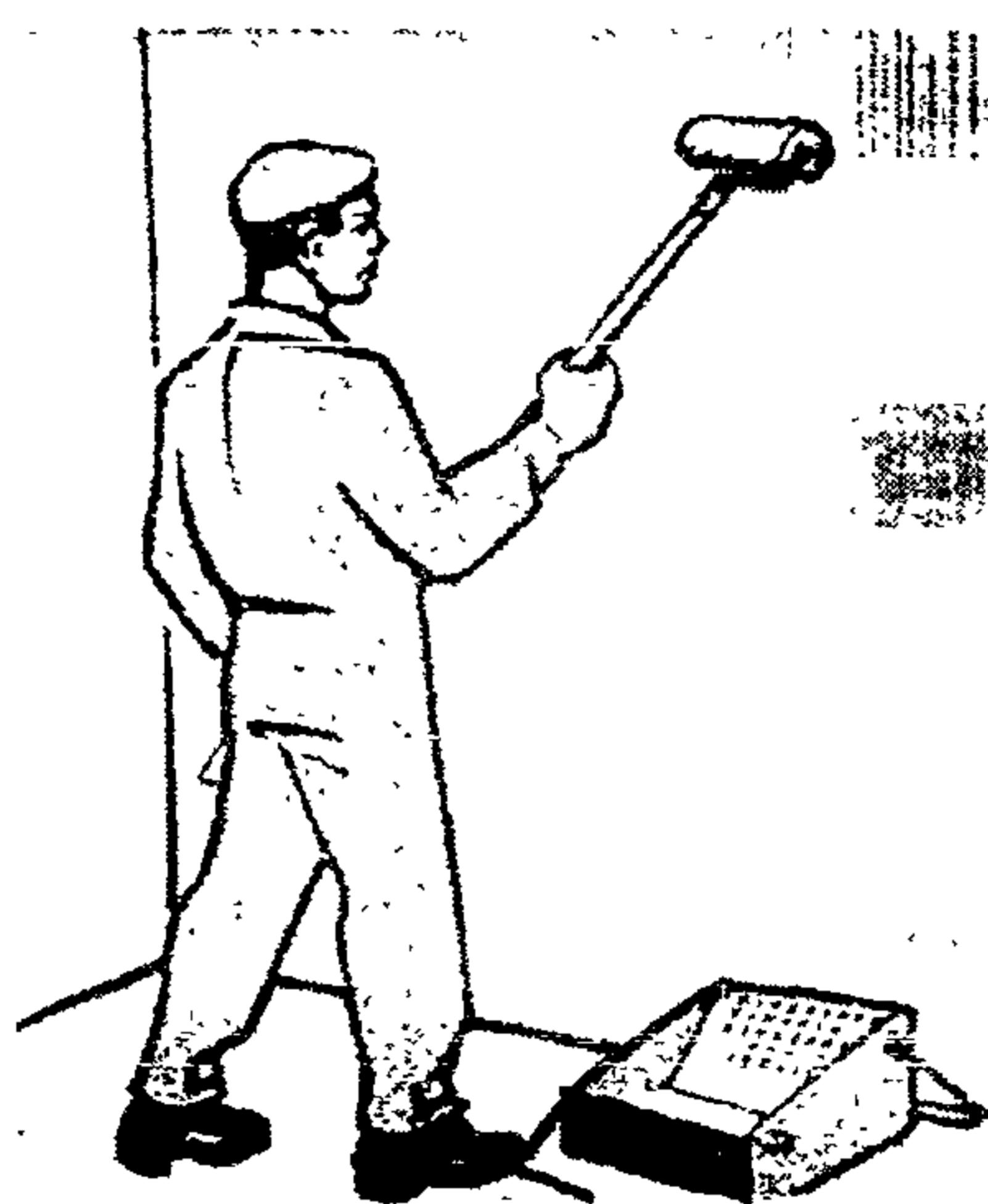
Рисунок 19 – Нанесение олифы на поверхность
