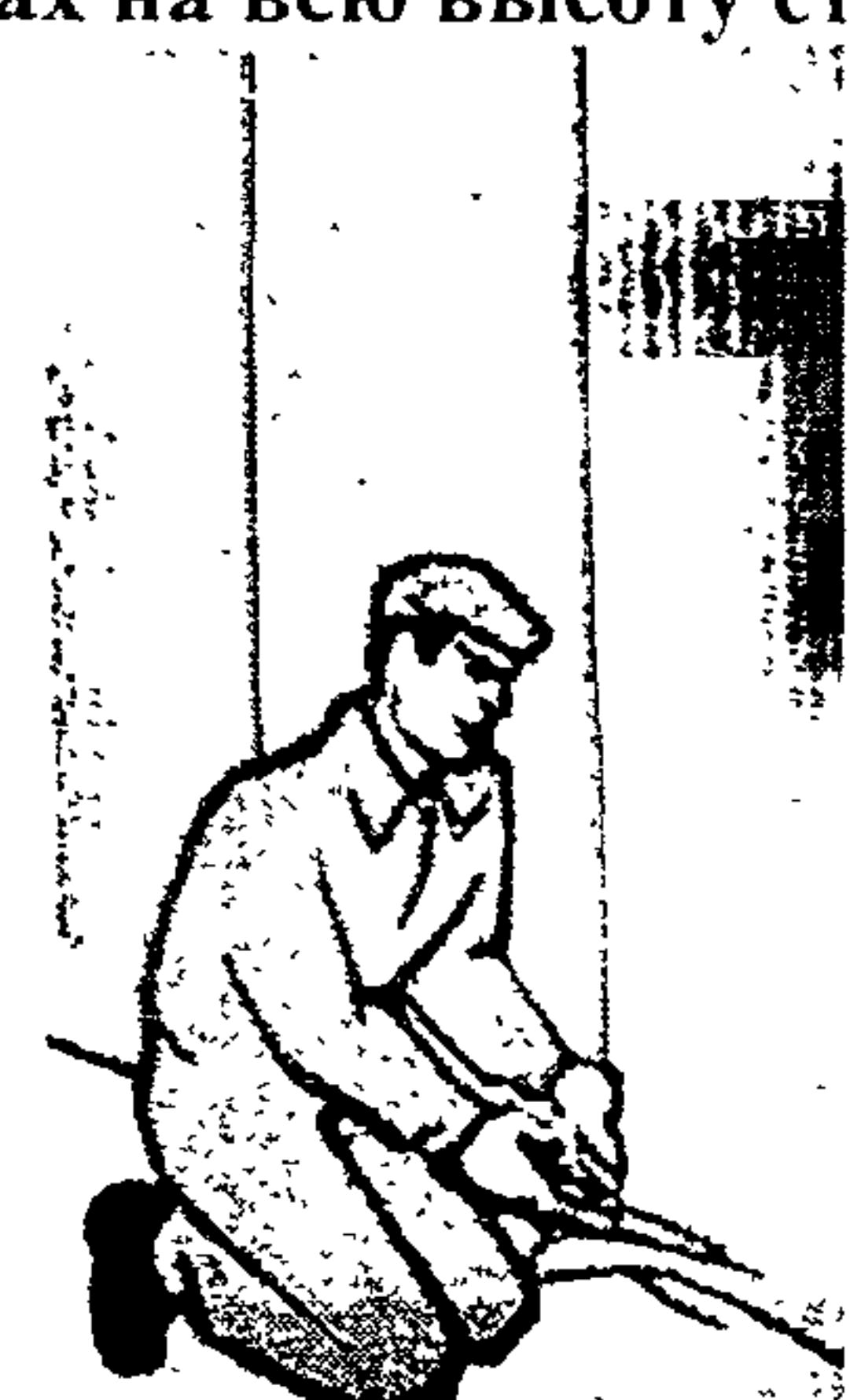
Рисунок 13 – Прирезка наклеенных полотнищ обояев у пола
