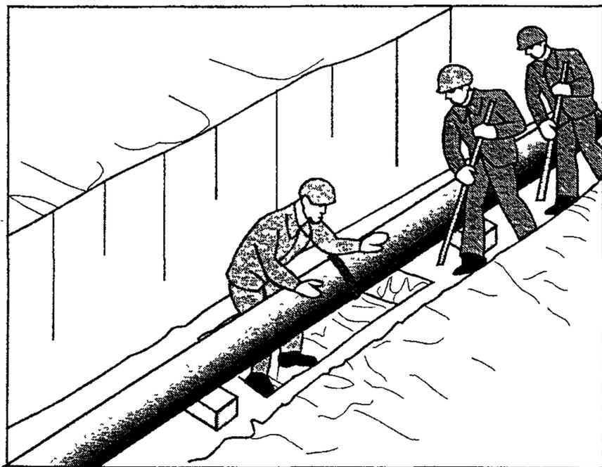
подает команду машинисту на подъем трубы (звена). Монтажники тем временем снимают распорки крепления траншеи в месте монтажа трубы (звена).
