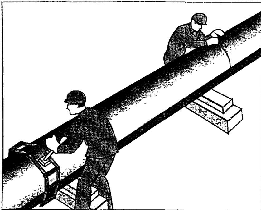
(1,5-2,5 мм по всей окружности стыка). В случае несоответствия величины зазора указанным размерам монтажники винтовым рычагом ослабляют центратор, машинист подъемом крюка делает натяжку стропа, а монтажники при помощи ломов изменяют величину зазора, после чего деревянными клиньями фиксируют положение трубы, и окончательно центрируют стык, затянув рычаг центратора до отказа.
