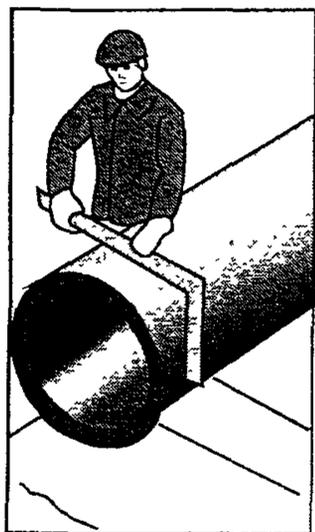
(трубы) положение оси трубопровода, а монтажники Т3 и Т4 по отвесу устанавливают на размеченные места вешки. Монтажник Т1, ориентируясь на вешку, установленную на ранее уложенную трубу, проверяет правильность укладки трубы (звена) в плане.
