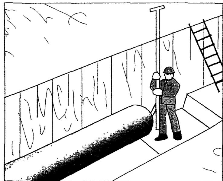
2.14 Выверка положения трубы (звена) производится монтажниками Т1 и Т2, один из которых (Т2) устанавливает на лоток укладываемой трубы (звена) ходовую визирку, а второй монтажник Т1, находясь у передней линии неподвижной визирки обноски, следит за тем, чтобы верх ходовой визирки находился на линии визирования. При необходимости он подает сигнал машинисту приподнять или опустить трубу (звено), а монтажники Т3 и Т4 срезают или подбивают грунт под трубой (звенном).
