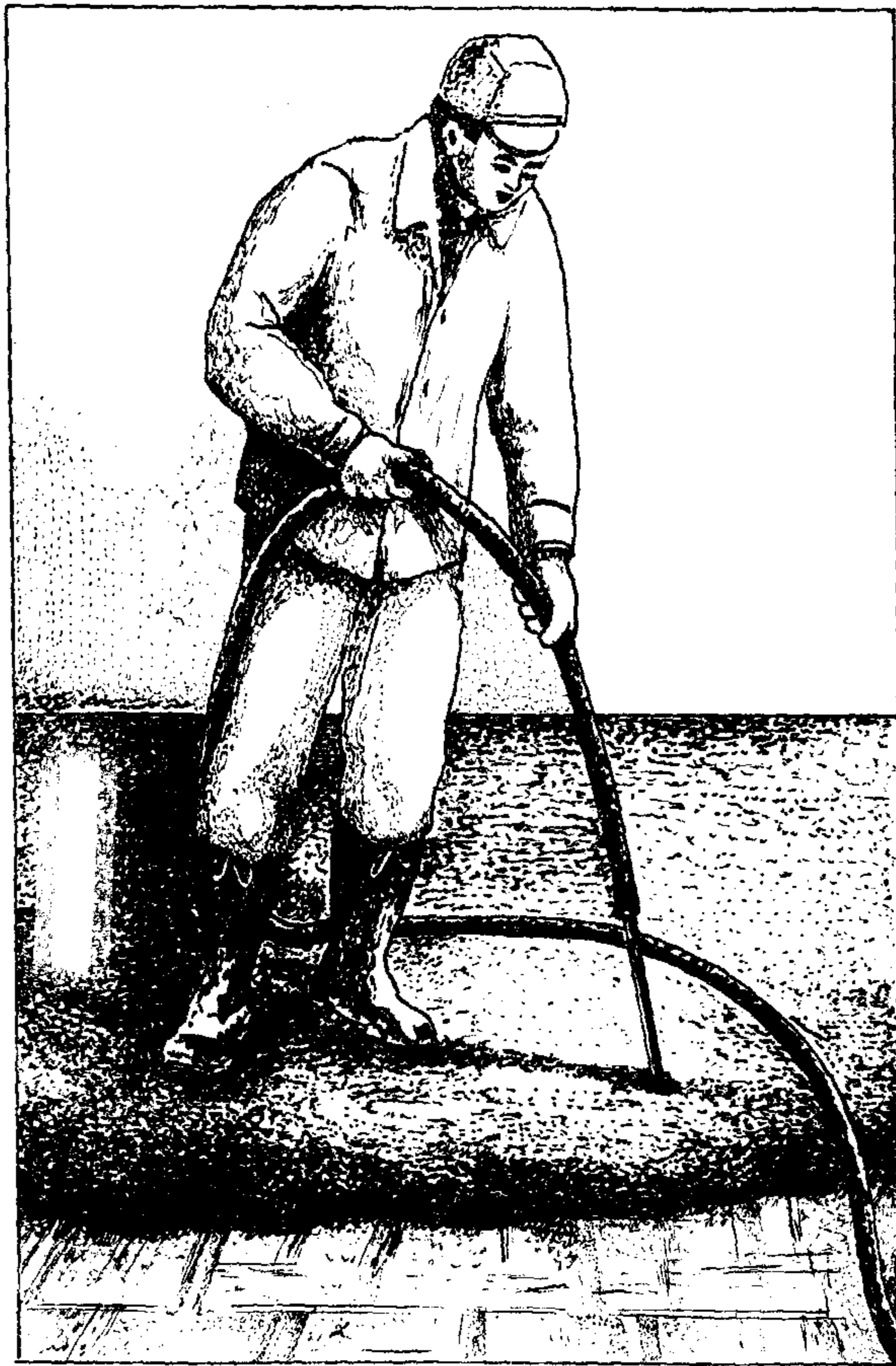
Рис. 1. Заливка самовыравнивающегося раствора
