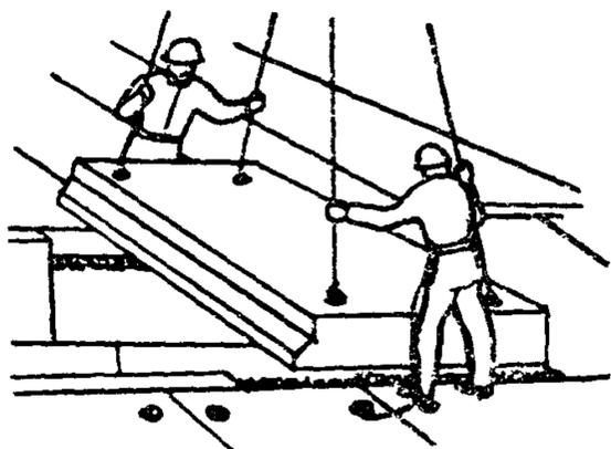
Машинист крана по команде монтажника М<sub>1</sub> подает площадку к месту укладки. Монтажники М<sub>1</sub> и М<sub>2</sub> принимают площадку на высоте 20-30 см от опорных поверхностей, разворачивают ее и опускают на подготовленную постель из раствора
