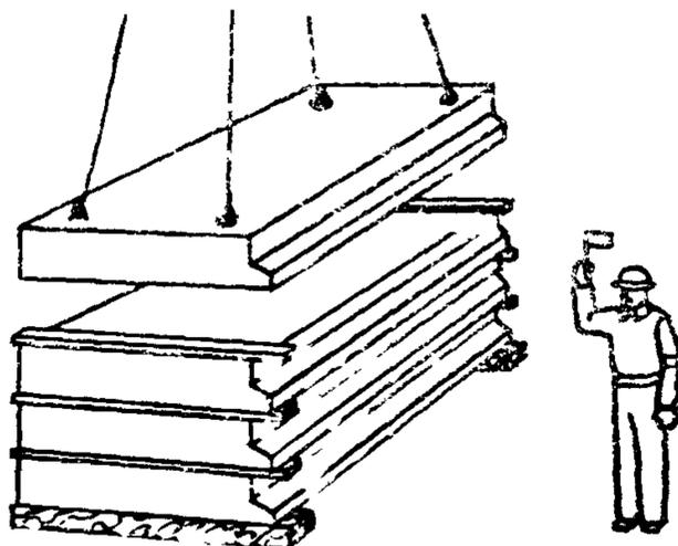
Такелажник стропит лестничную площадку, отходит от нее на 4-5 м и подает команду машинисту крана приподнять площадку на 20-30 см. Убедившись в надежности строповки, он сигнализирует машинисту на подачу площадки к месту монтажа
