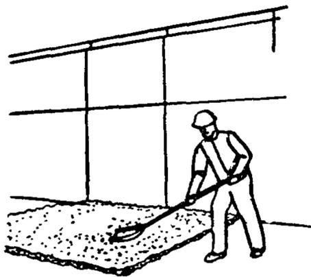
Монтажники  $M_1$  и  $M_2$  лопатами набрасывают необходимое количество песка на место установки кабины, а затем разравнивают его до проектной отметки
