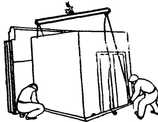
нения путем рихтовки кабины полами и подсыпки песка. Затем монтажники открывают предохранительные устройства и поочередно освобождают карабины стропов траверсы из монтажных петель кабины. Машинист крана поднимает траверсу, а монтажники еще раз проверяют правильность установки кабины при помощи отвеса-рейки
