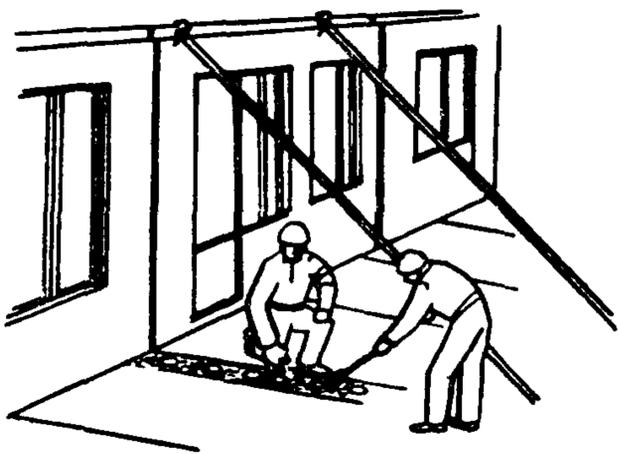
Монтажник М<sub>2</sub> лопатой подает на место установки блока раствор, а монтажник М<sub>1</sub> кельмой разравнивает его между каналами нижеустановленного блока слоем на 5-8 мм выше установленных ранее маяков, с отступом от граней каналов в 15-20 мм
