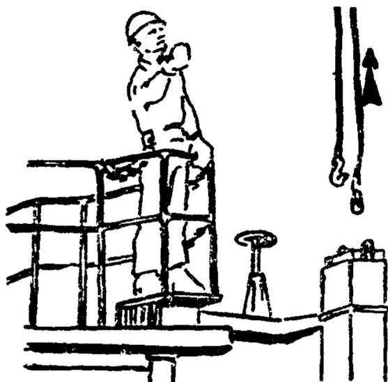
После установки и закрепления колонны машинист крана ослабляет натяжение ветвей строба, а монтажник  $M_2$ , стоя на верхней площадке РШН, расстроповывает колонну и подает команду машинисту крана поднять строп
