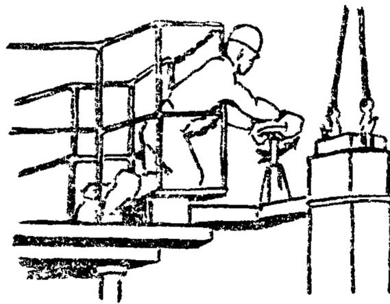
Равномерное притяжение колонны обеспечивается установленной на хомуте скобой, отклоняющей трос. Монтажник  $M_1$  прикладывает приспособление для проверки вертикальности к ребру колонны так, чтобы оно опиралось своими внутренними упорами на две плоскости, и следит за положением урвней, позволяющих производить выверку колонны
