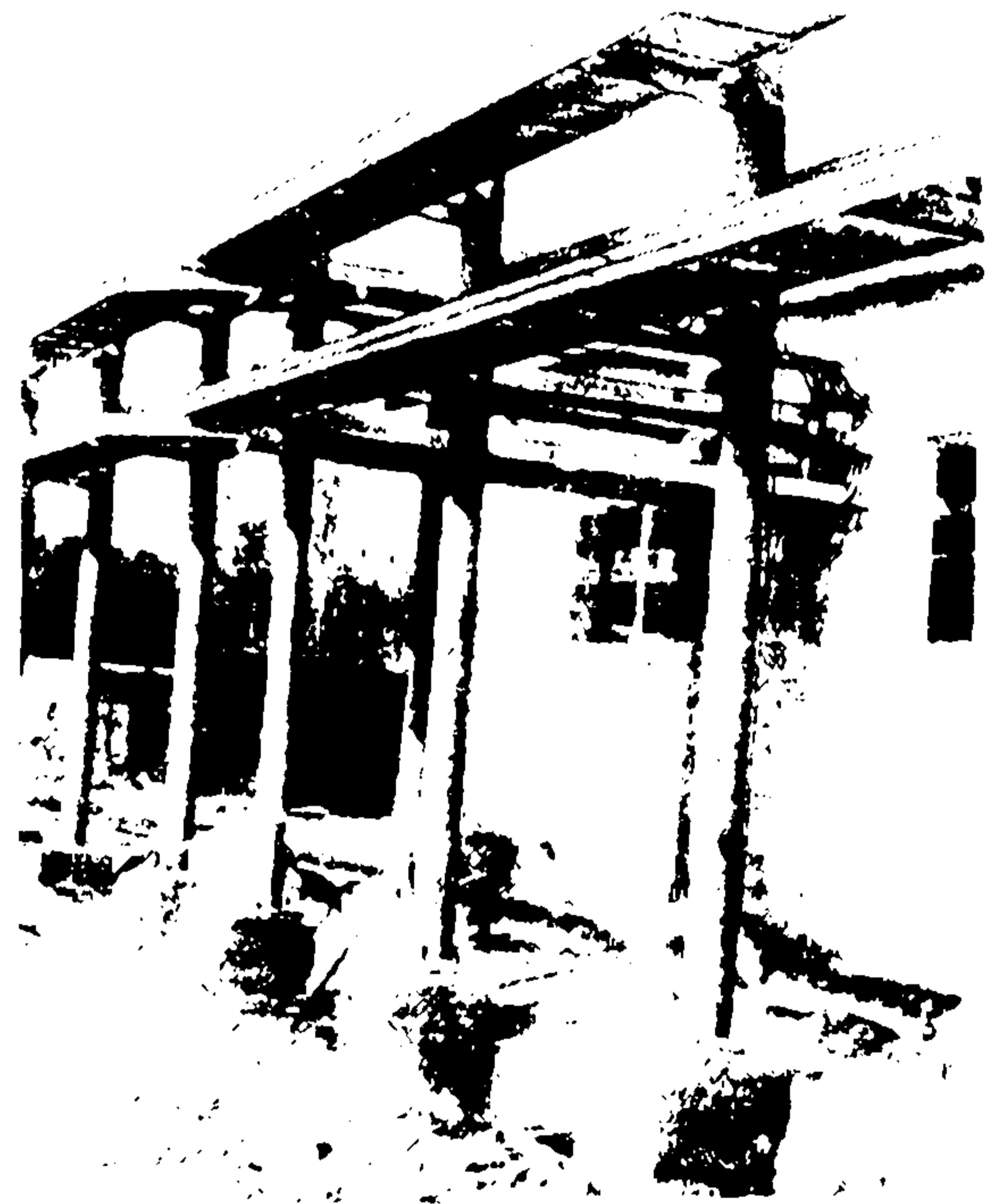
Рис.6. Опорные элементы из монолитного железобетона:
