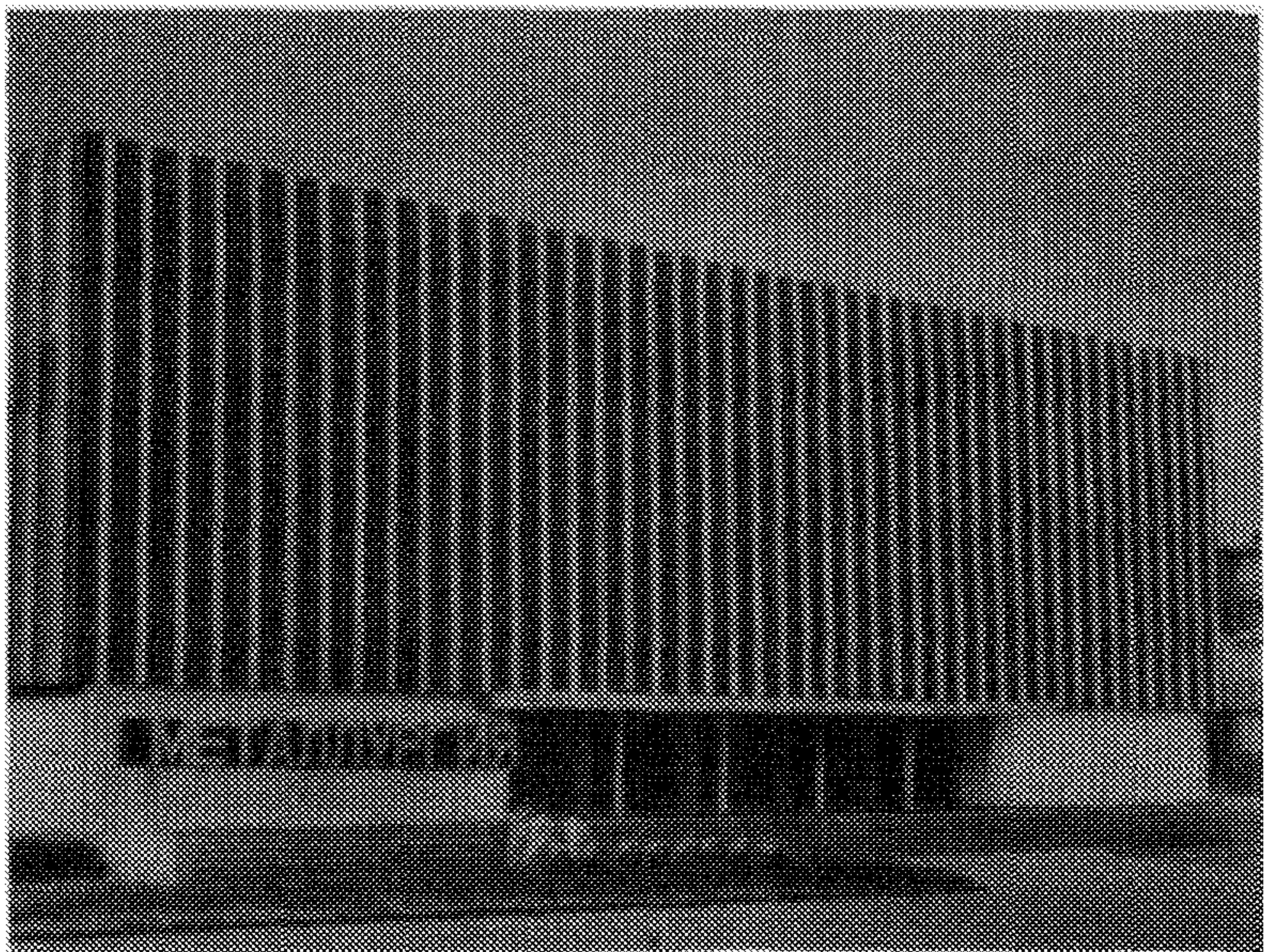
Рис. 25. Павильон "Металлургия" на ВДНХ СССР, облицованный шлакоситаллом
