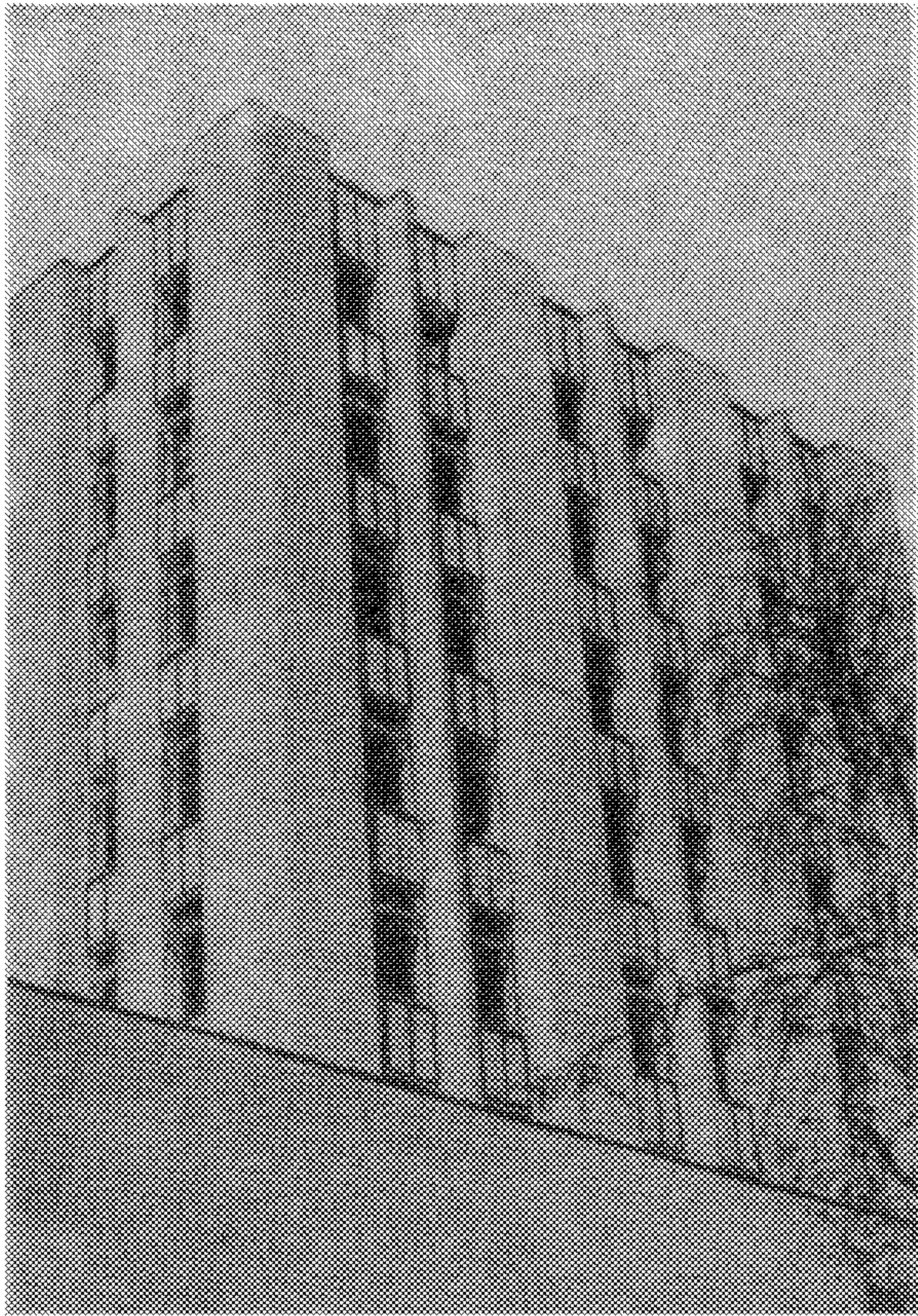
Рис. 19. Гуманитарный корпус № 2 МГУ, облицованный молочным накладным стеклом
