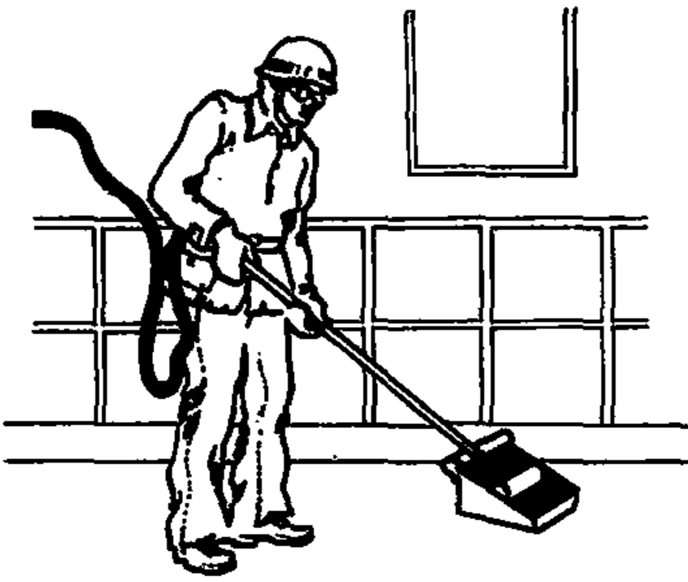
Рис. 15. Удаление с валика излишков раствора
