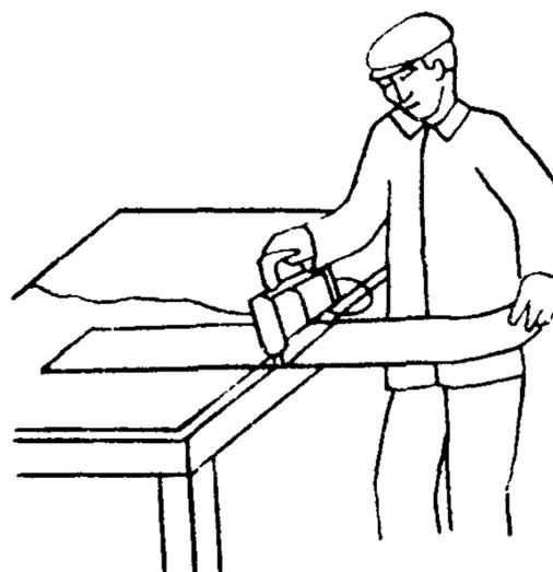
Кровельщик K<sub>1</sub> электроножницами разрезает лист оцинкованной кровельной стали вдоль на три равные по ширине полосы, затем каждую длинную полосу на две короткие, каждую короткую на ленты шириной 35 мм и, наконец, каждую ленту
