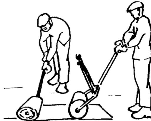
Кровельщик К<sub>2</sub> заводит каток на приклеенный участок рулона, а кровельщик К<sub>3</sub> вставляет ось катка в рулон
