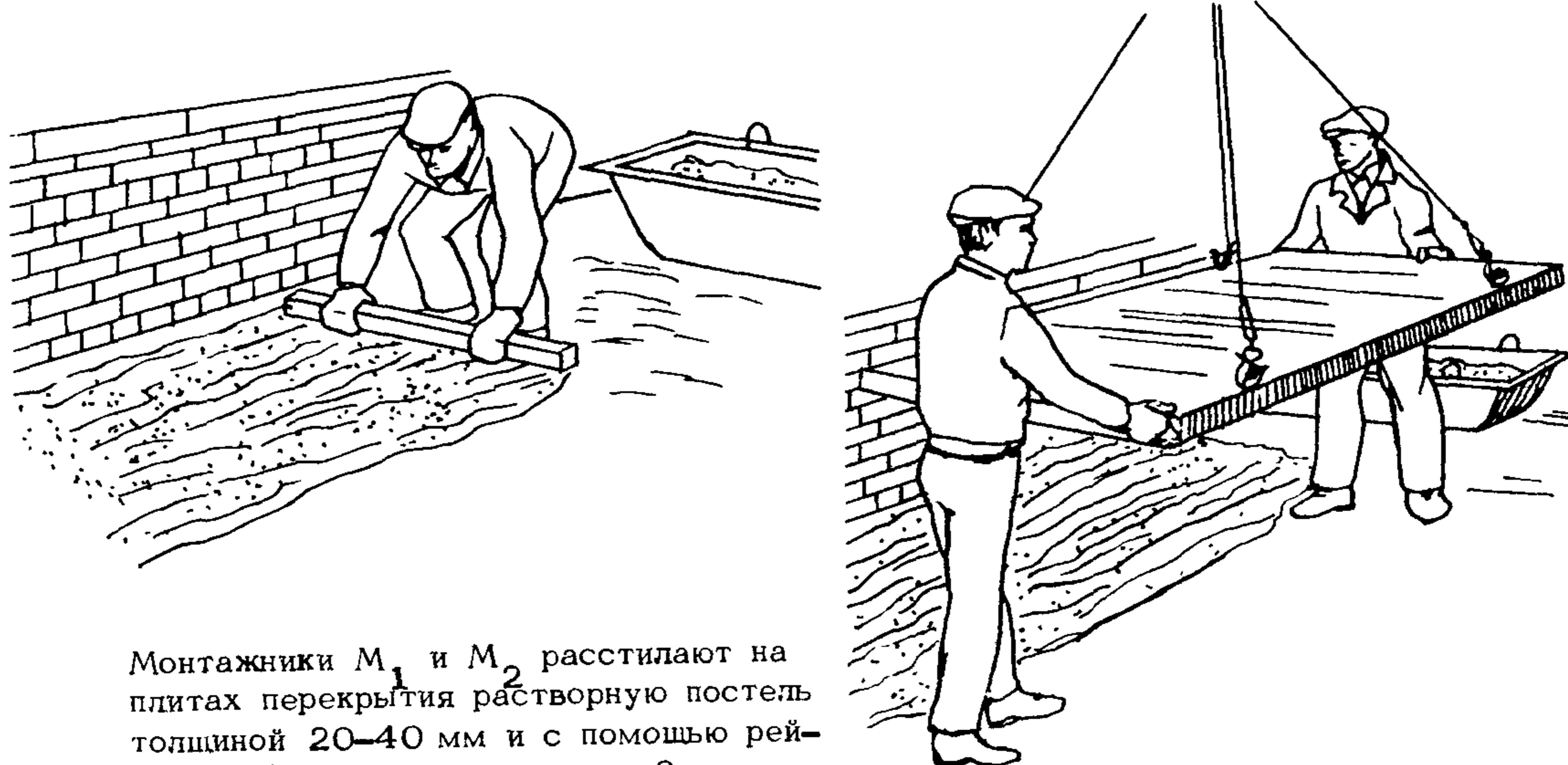
Монтажники  $M_1$  и  $M_2$  расстилают на плитах перекрытия растворную постель толщиной 20–40 мм и с помощью рейки-правила разравнивают ее. Затем они принимают поданный краном поддон на расстоянии 40–50 см от перекрытия и опускают его рядом с местом установки. Расстропив поддон и загнув монтажные петли, монтажники повторно строят его за две петли.
