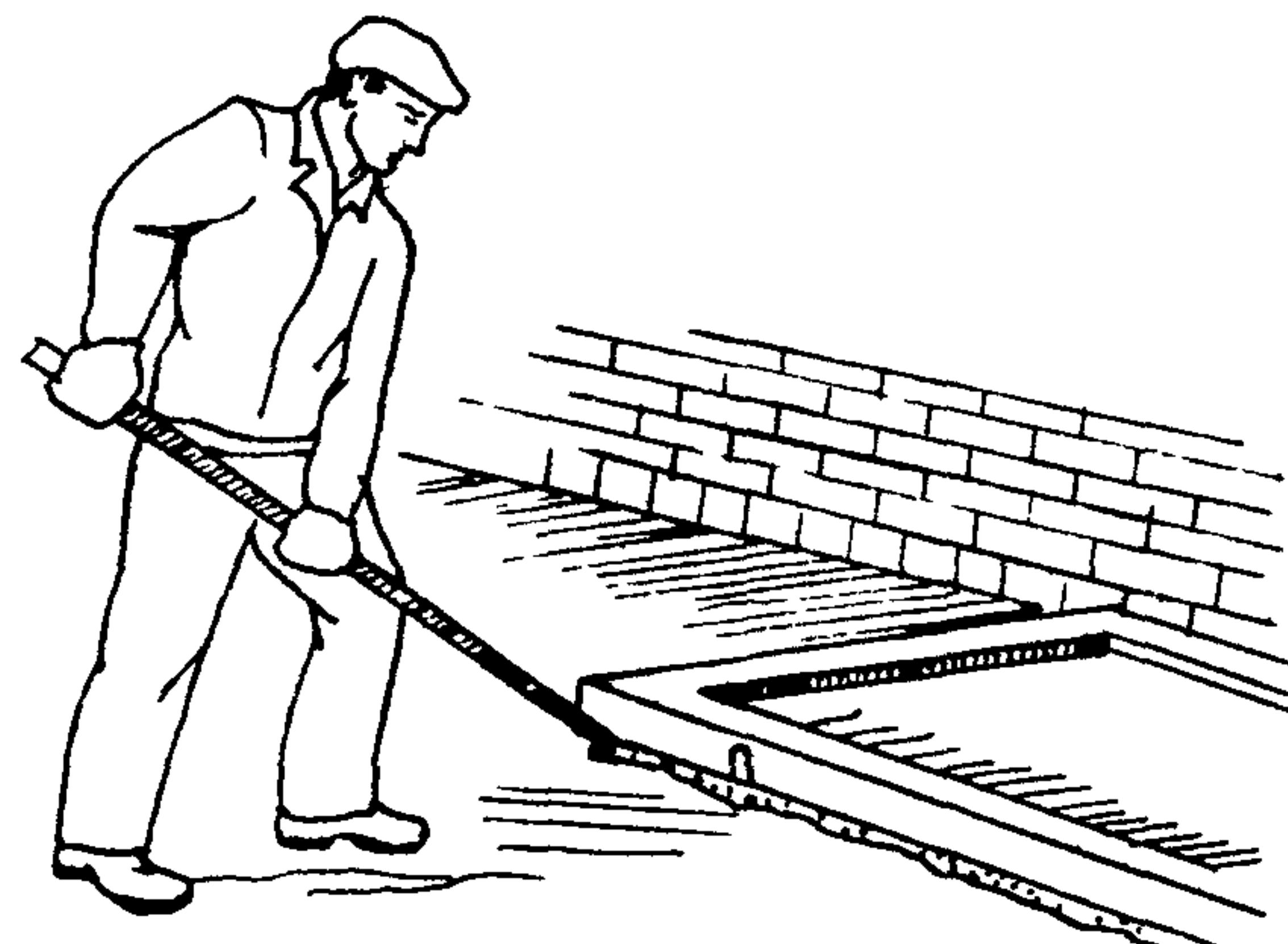
Монтажники  $M_1$  и  $M_2$ , удостоверившись в правильности установки поддона, расстроповывают его и ломами рихтуют до точного совпадения углов, прилегающих к кирпичной стене, с нанесенными на нее рисками. Затем они полностью загибают молотком монтажные петли, подбирают выжатый на поверхность раствор и заделывают им шов между поддоном и кирпичной стеной. Горизонтальность поддона проверяют при помощи рейки и уровня
