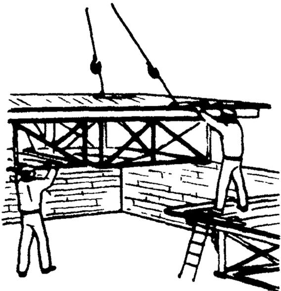
По сигналу такелажника Т<sub>1</sub> машинист крана приподнимает подмости на 20-30 см, а такелажник, находясь на безопасном расстоянии, визуально проверяет натяжение тяг. Убедившись в надежности строповки, он подает команду машинисту крана переместить подмости к месту установки. Монтажник М<sub>1</sub> и такелажник Т<sub>2</sub> принимают подмости и ориентируют их над местом установки
