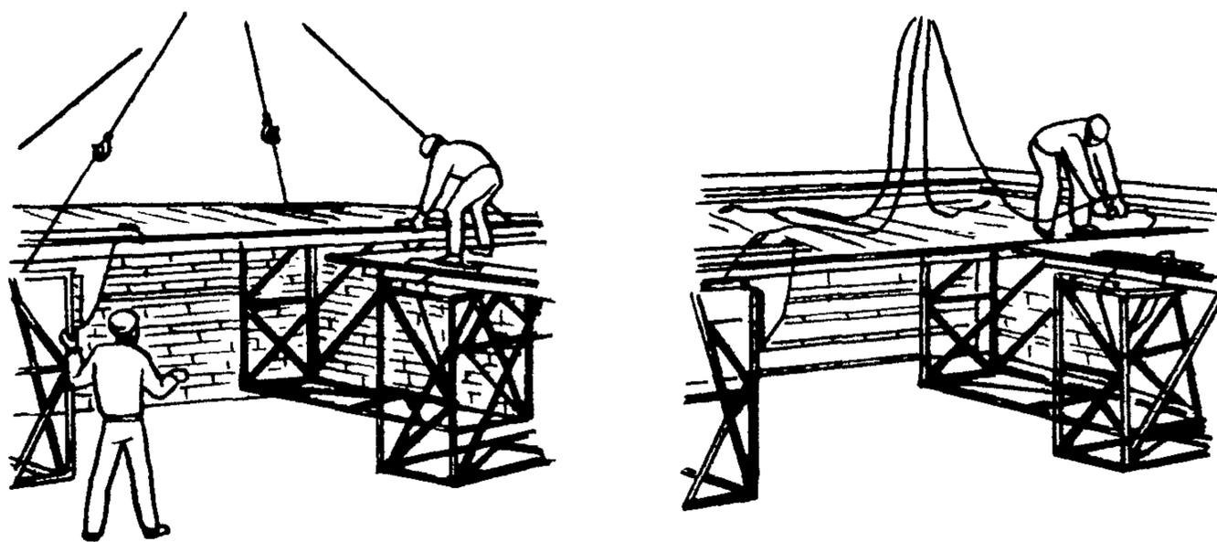
После полного раскрытия опор монтажник М<sub>2</sub> и такелажник Т<sub>3</sub> следят за установкой подмостей на перекрытие, при необходимости регулируя ломом их положение. Затем они поднимаются по приставной лестнице на подмости и расстроповывают их, опуская петли в углубления подмостей
