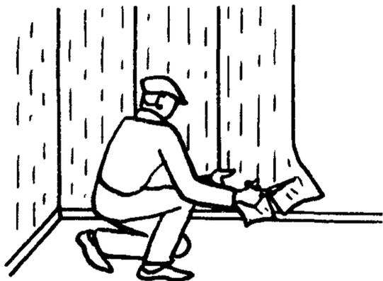
Маляры  $M_1$  и  $M_2$  прирезают наклеенные полотнища обоев в местах примыкания к электроарматуре, выступающим частям конструкций и у пола
