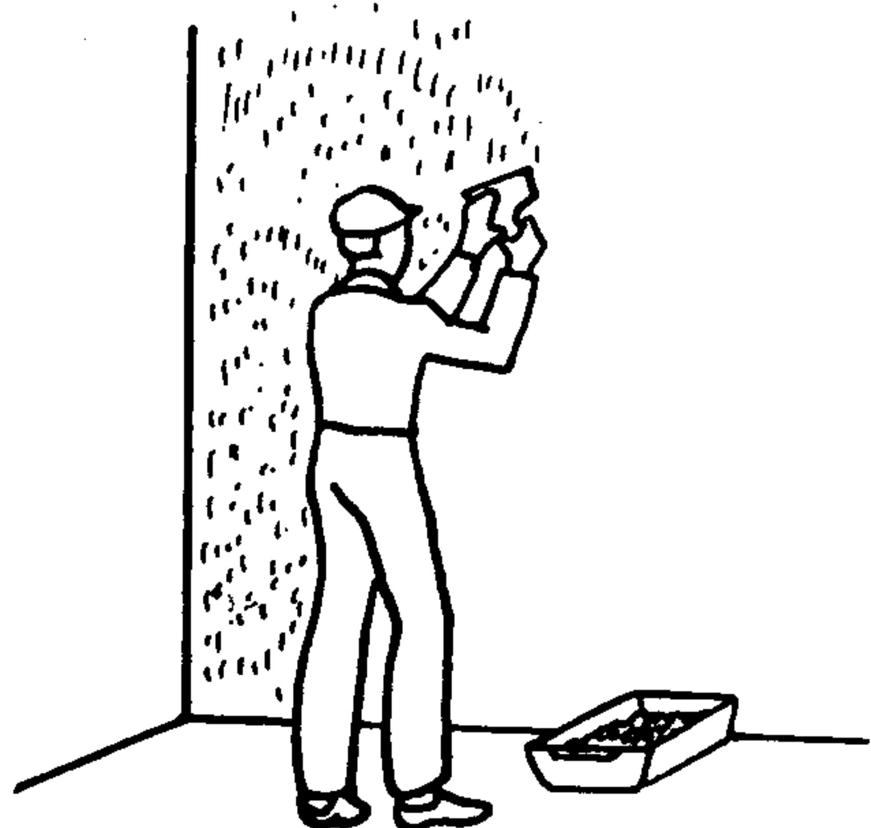
Маляры  $M_1$  и  $M_2$ , работая самостоятельно, при помощи шпателей наносят шпаклевку на поверхность стен ровным слоем толщиной до 2 мм. Сглаживают шпаклевку движениями сверху вниз и слева направо. При нанесении и сглаживании шпаклевки шпатель держат под углом  $10-15^\circ$  к поверхности стены
