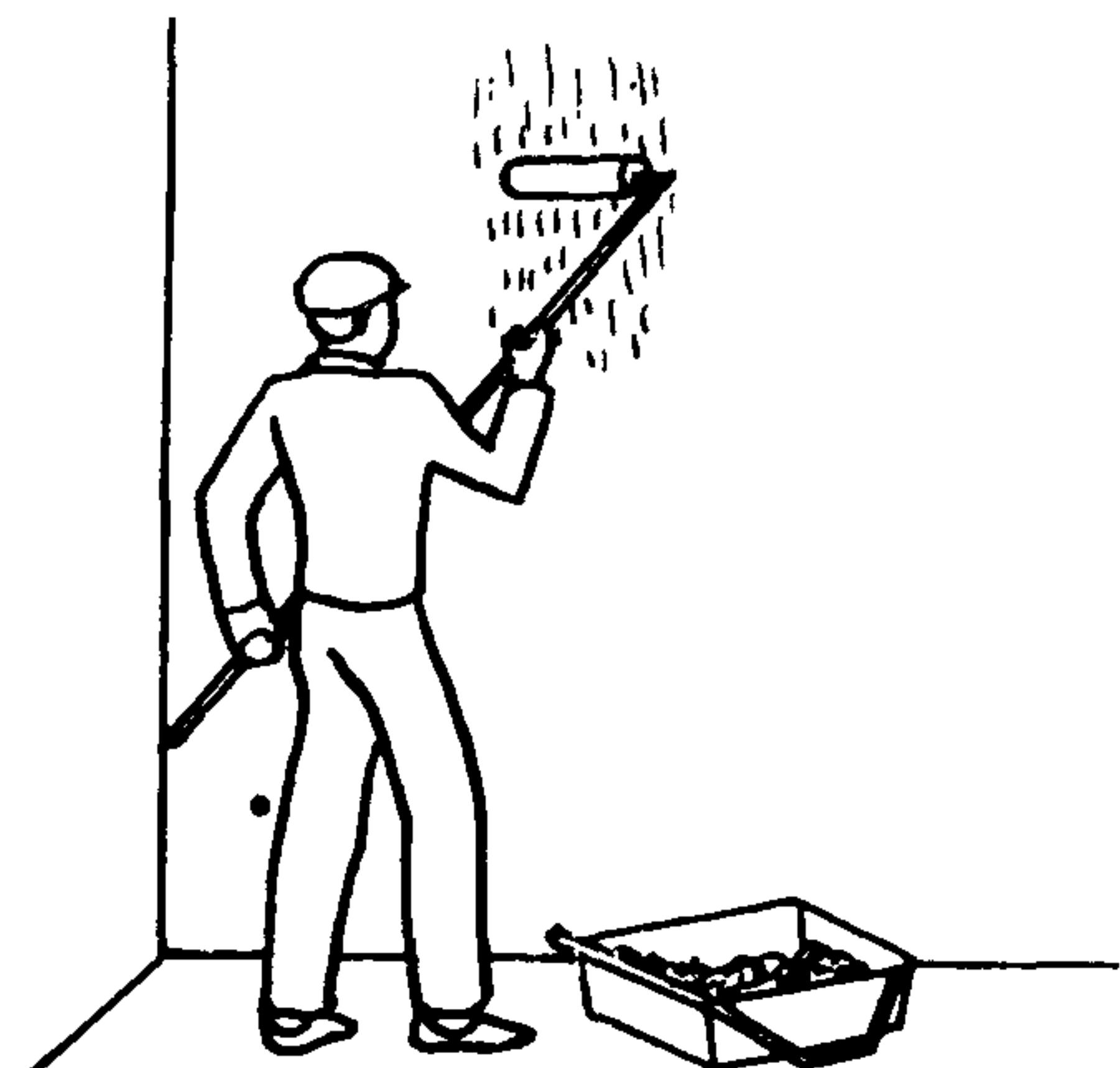
Маляр  $M_1$  погружает валик в ванночку с грунтовкой и прокатывает его по сетке для снятия излишков, после чего наносит грунтовку на обрабатываемую поверхность. Маляр  $M_2$  готовит раствор мыловара и подносит его к рабочему месту
