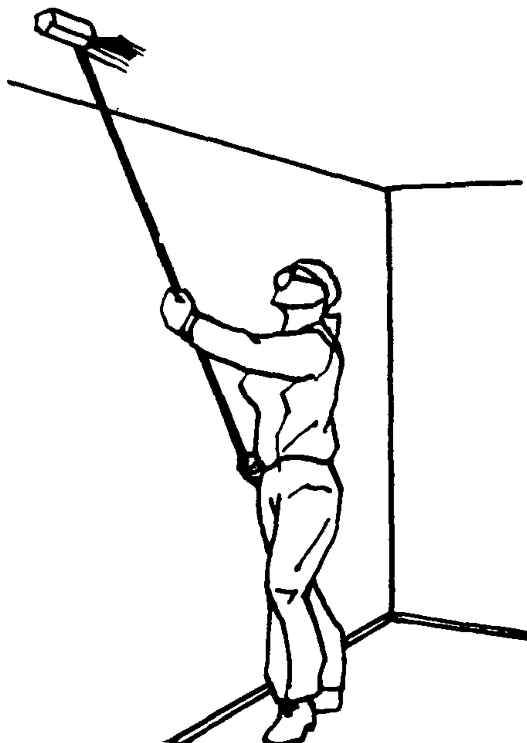
Маляр  $M_1$ , держа шлифовальное приспособление так же, как скребок, прикладывает рабочую часть его к обрабатываемой поверхности потолка и поступательно—возвратными движениями сглаживает ее, перемещаясь вперед по мере обработки поверхности
