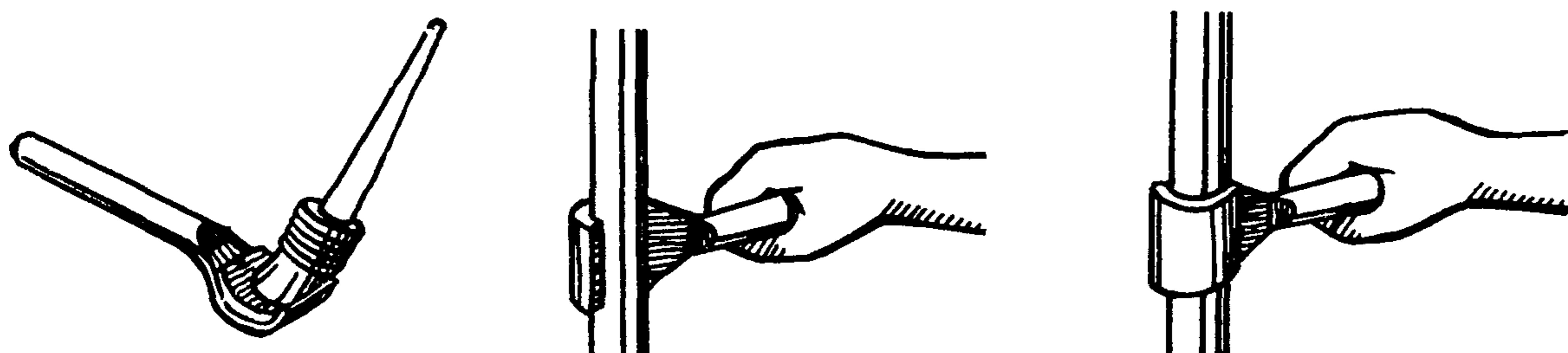
С помощью кисти маляр наносит на вогнутую (оклеенную мехом) поверхность приспособления олифу. Затем смоченное олифой приспособление маляр заводит в промежуток между стеной и трубой и движениями вверх и вниз олифит трубу со всех сторон
