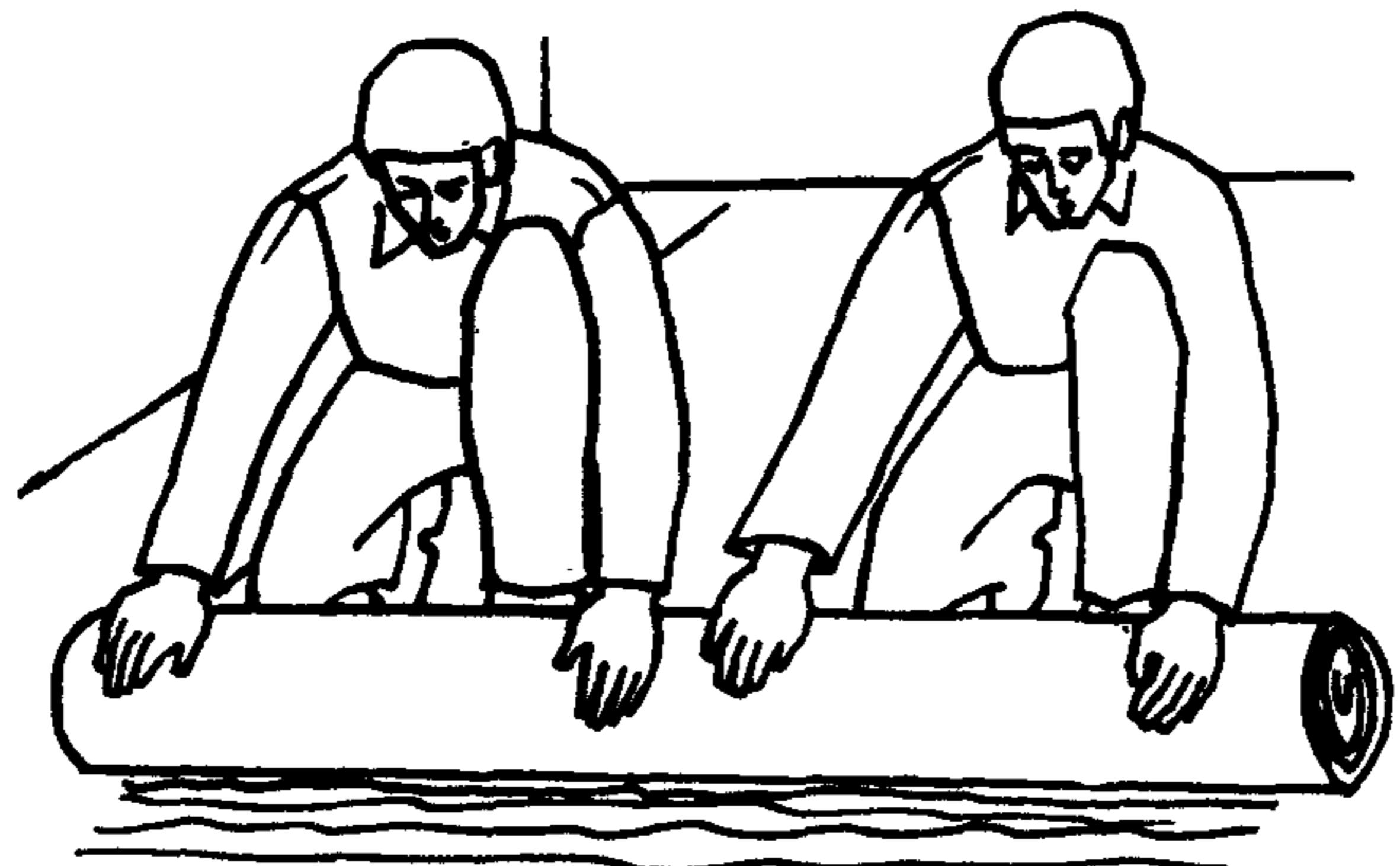
Облицовщики О<sub>1</sub> и О<sub>2</sub> раскатывают свернутую часть полотнища линолеума, плотно прижимая его к намазанному kleem основанию, а затем щеткой разглаживают полотнище от его середины к краям. Кромки полотнища шириной 8–10 см остаются неприклеенными
