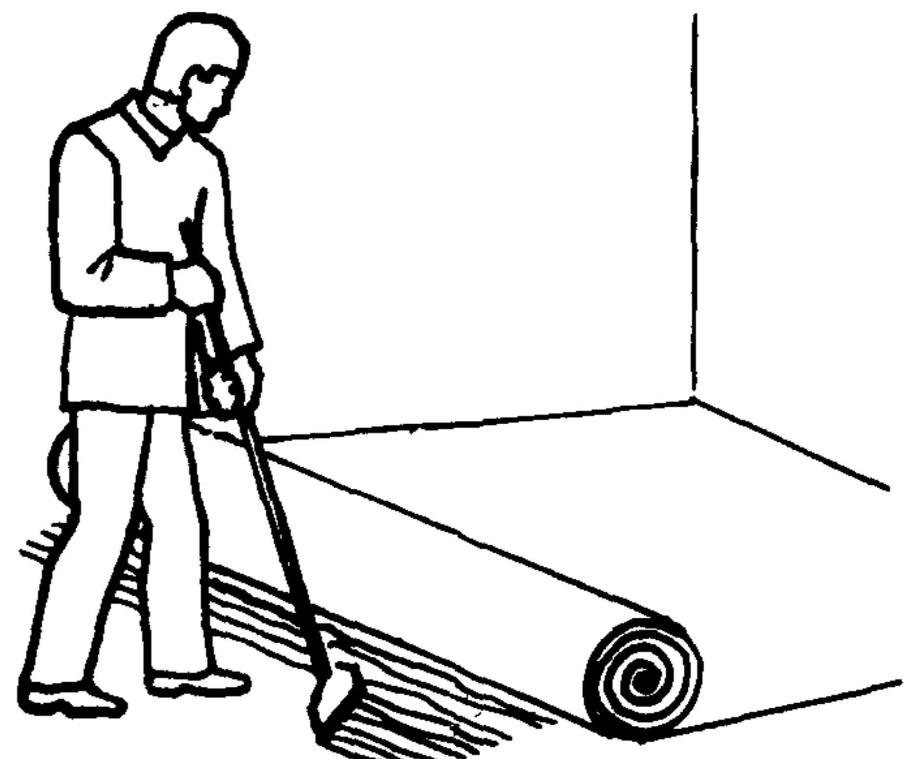
Облицовщик О<sub>1</sub> гребенкой разравнивает клей, формируя слой толщиной 0,6–0,7 мм. При этом он оставляет на продольных стыках полотнищ ненамазанные полосы шириной 8–10 см
