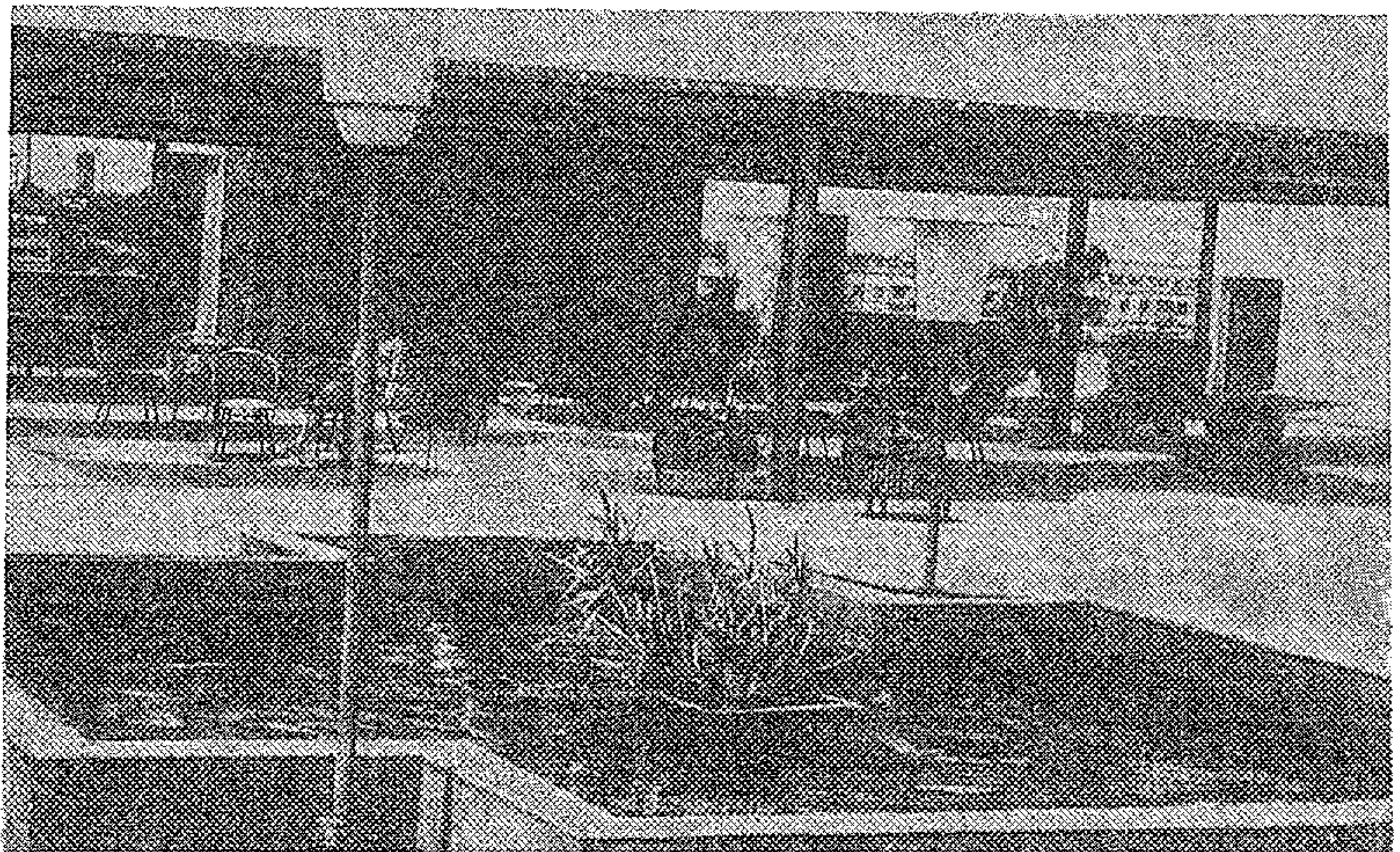
Рис.10. Пример размещения места отдыха на кровле промышленного здания. Швейная фабрика им.40-летия ВЛКСМ (Тирасполь)
