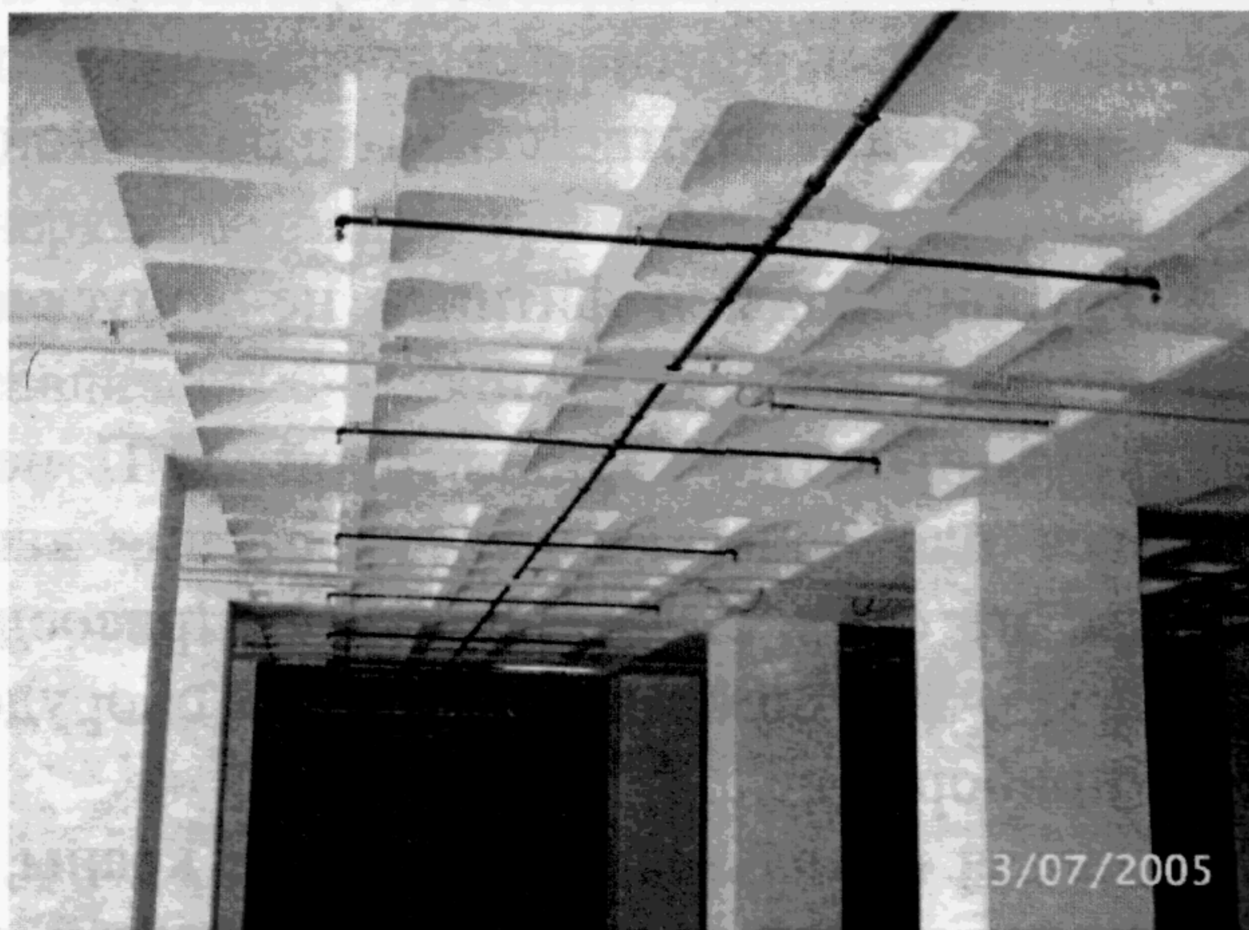
Рисунок 4.1 – Пример монтажа трубопроводов
