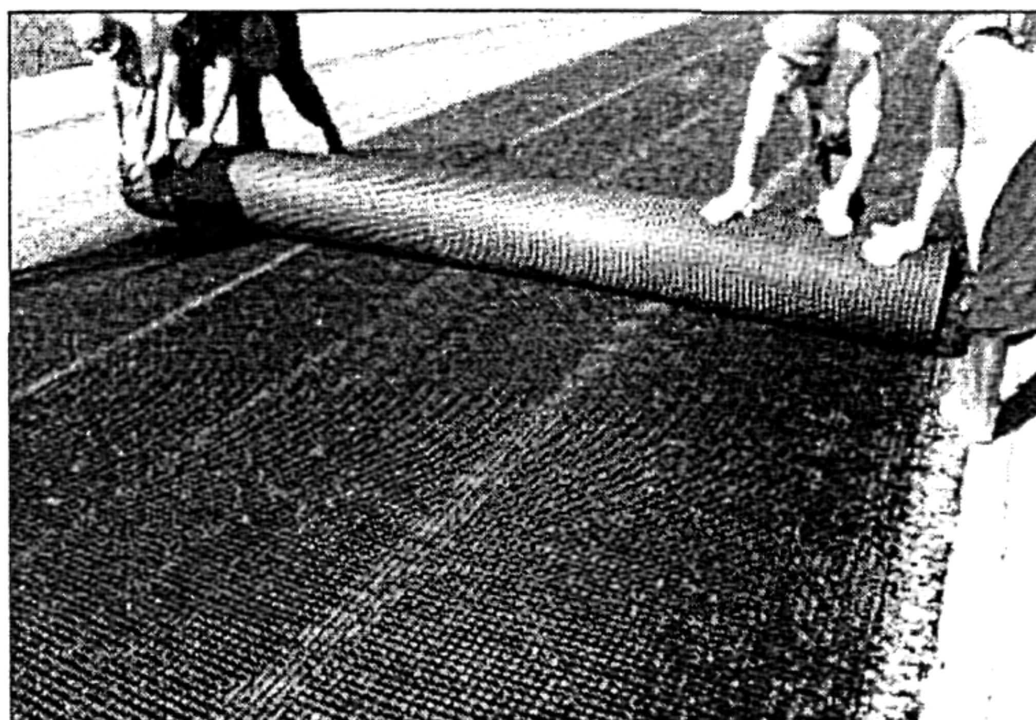
Рисунок 5. Укладка геосетки вручную
