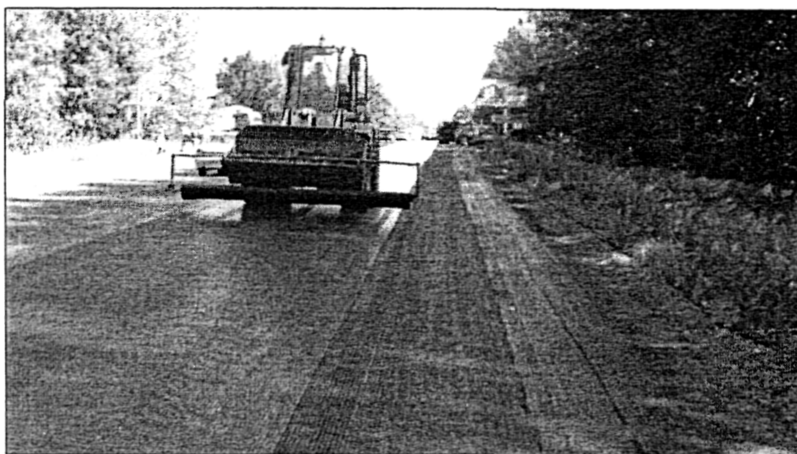
Рисунок 4. Пример укладки геосетки на основание
