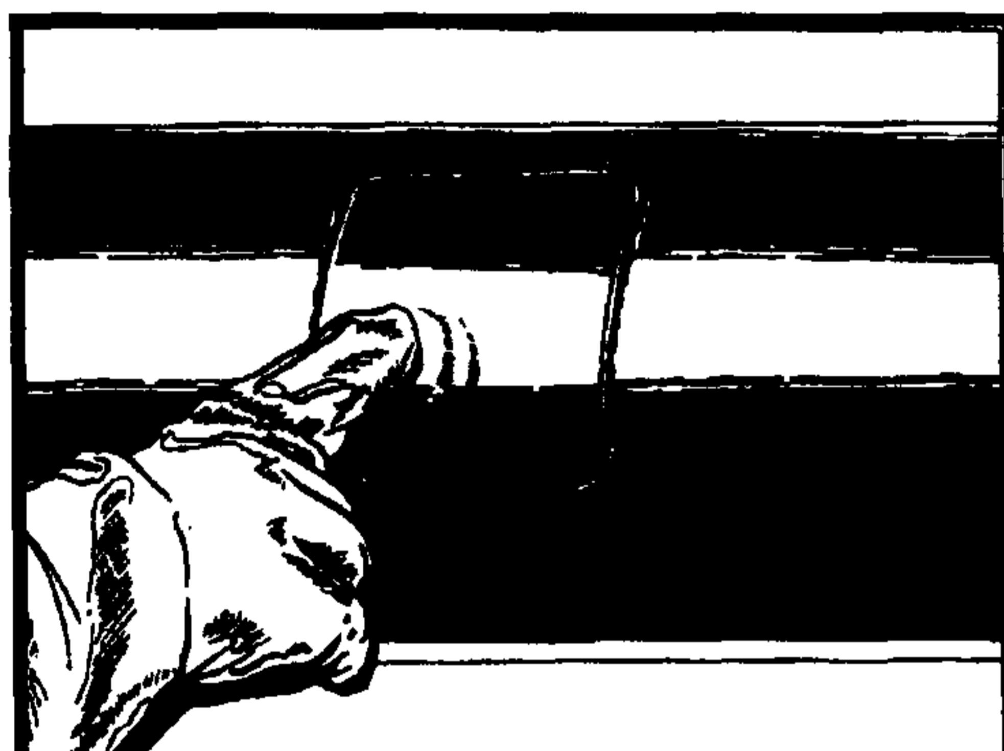
Рис. 6. Прикатка и уплотнение заплаты на ремонтируемом участке
