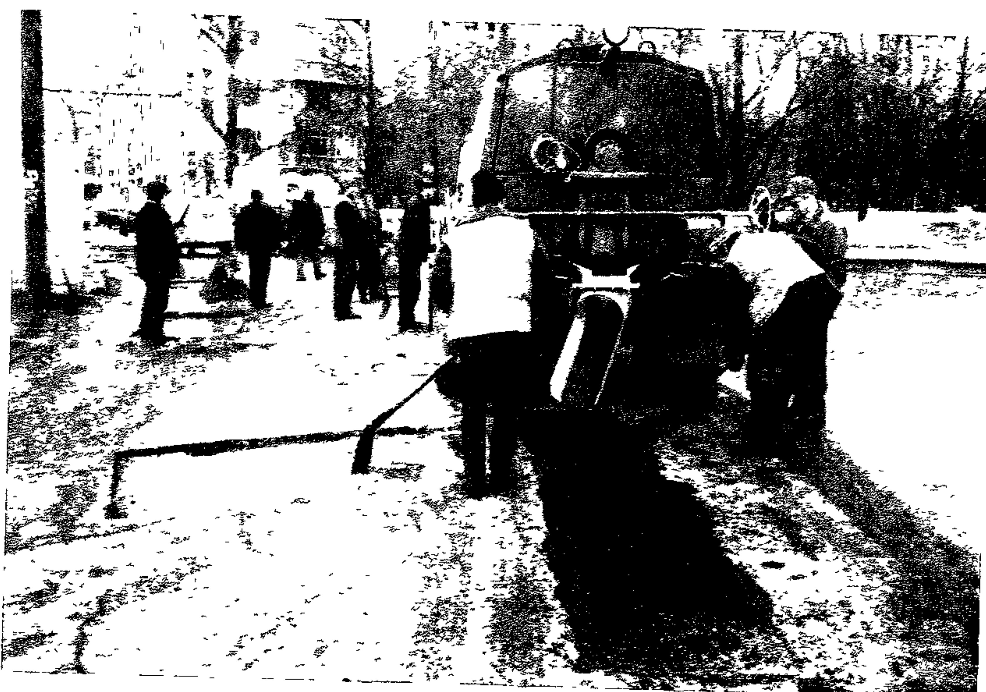
*Рис. 9. Ремонт дорожного покрытия ливой смесью
