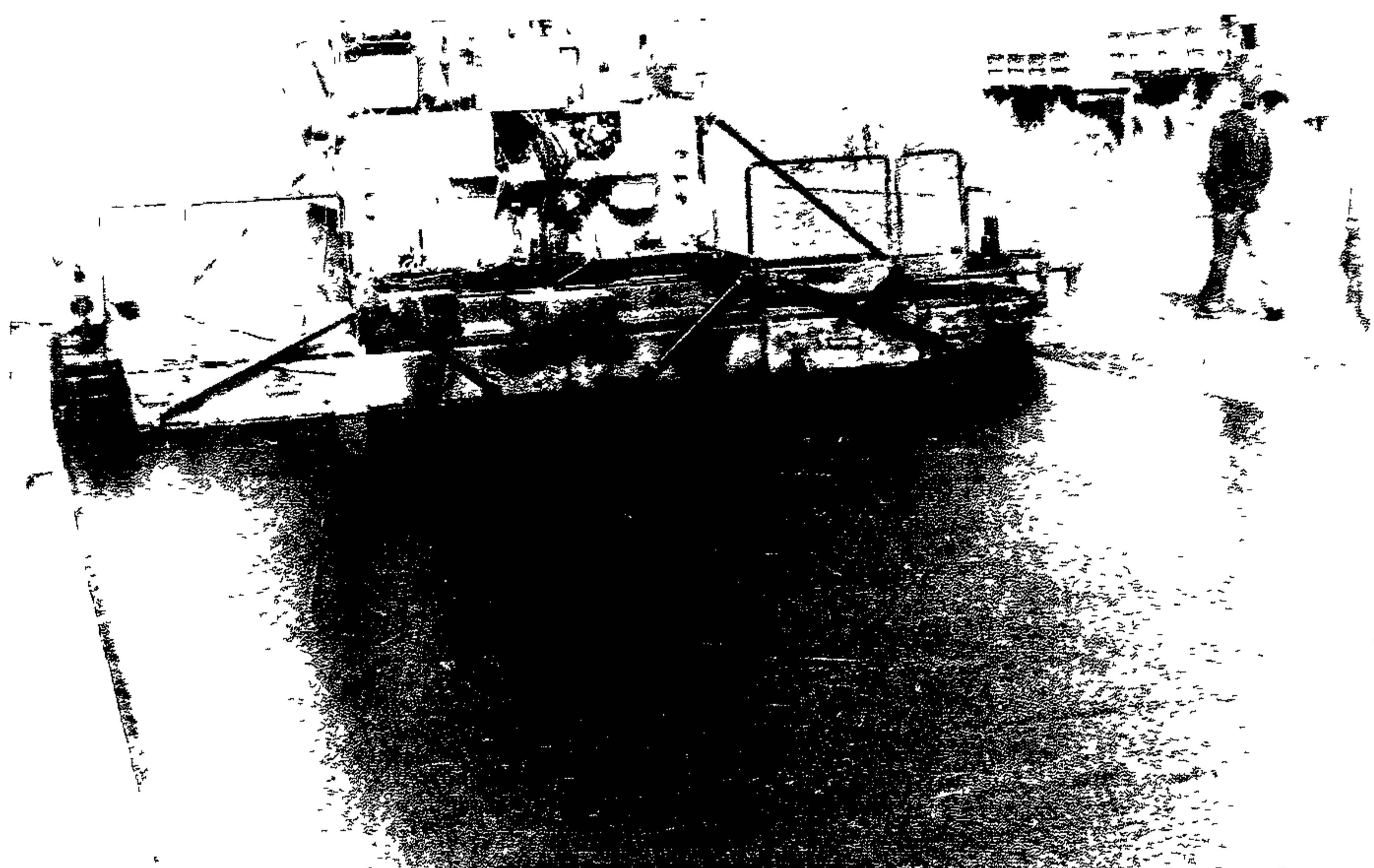
**Рис. 8. Укладка листой асфальтобетонной смеси II типа асфальтоукладчиком Супер-1800 при строительстве дорожного покрытия на городской автомагистрали**
