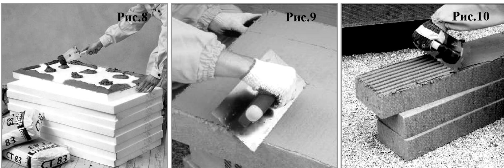
При монтаже двухслойных минераловатных плит с повышенной плотностью наружного слоя клеевой состав для приклеивания должен наноситься на мягкую сторону плиты.
