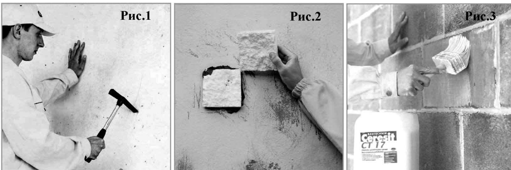
Следует проверить строительное основание на наличие отклонений от плоскости. Неровности основания не должны превышать допустимые отклонения ограждающих конструкций согласно табл. 11, 12, 34 СНиП 3.03.01 «Несущие и ограждающие конструкции». Рекомендуется устранить неровности, превышающие значение 1 см во всех направлениях при проверке 2-х метровым правилом. Если основание не отвечает этим требованиям, его необходимо выровнять строительным раствором (например, Ceresit СТ 29 или Ceresit СТ 24).
