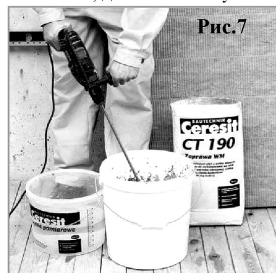
В процессе работы консистенцию смеси поддерживают за счет ее повторного перемешивания. Добавление воды в смесь не допускается.
