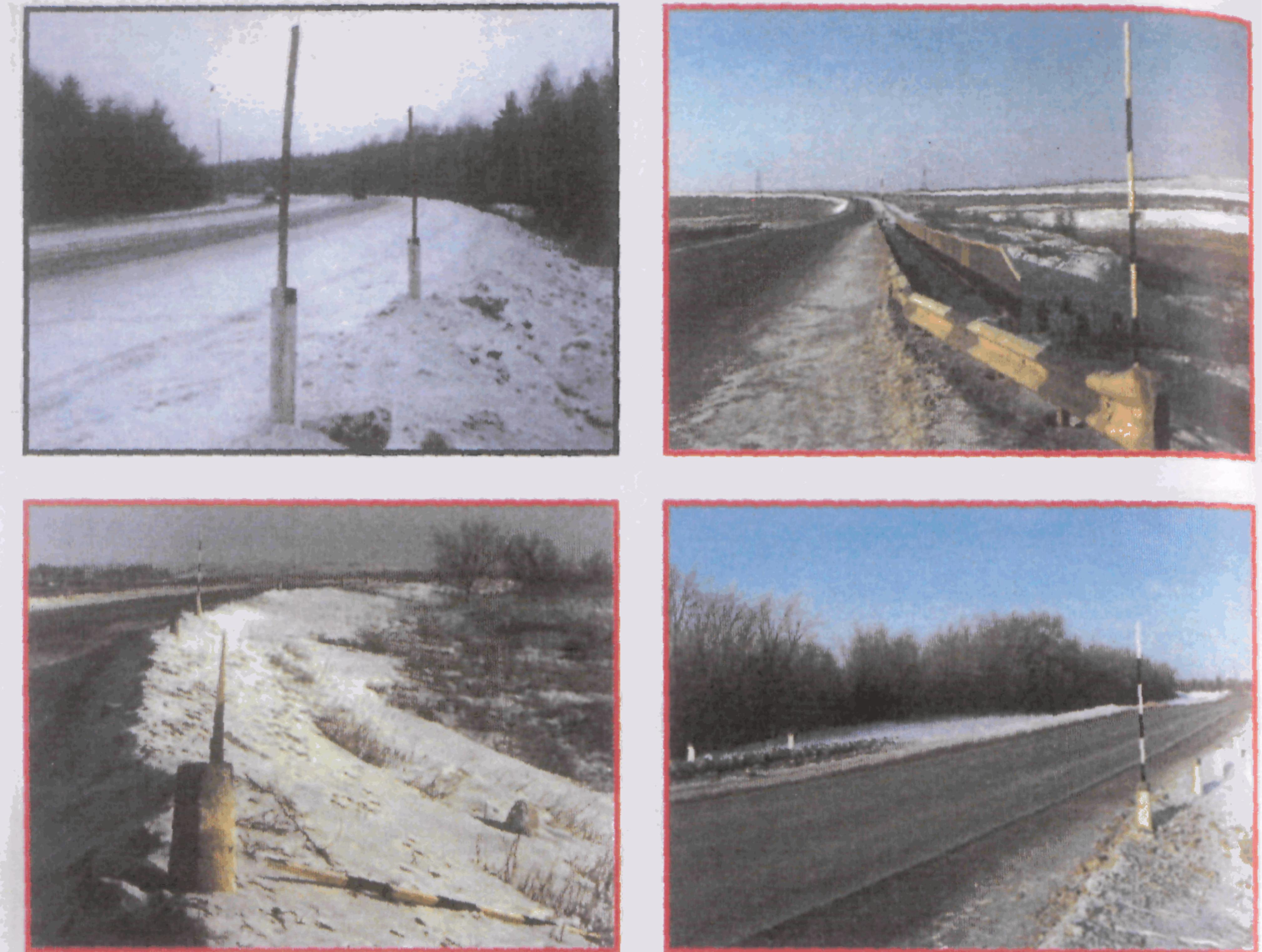
**Установка указательных вех в местах расположения труб, сигнальных столбиков, барьерного ограждения, начала и конца мостов, участков дорог с насыпью более 2 м и на участках кривых малого радиуса**
