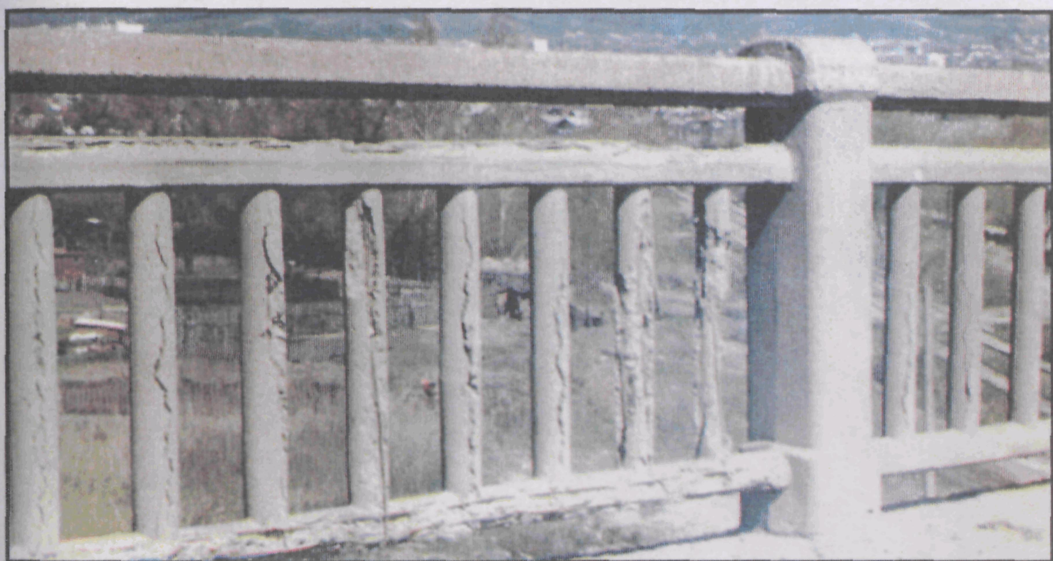
**Отдельные поверхностные повреждения перильных ограждений, ограждений элементов пролетных строений, подлежащих восстановлению в течение 5 суток**
