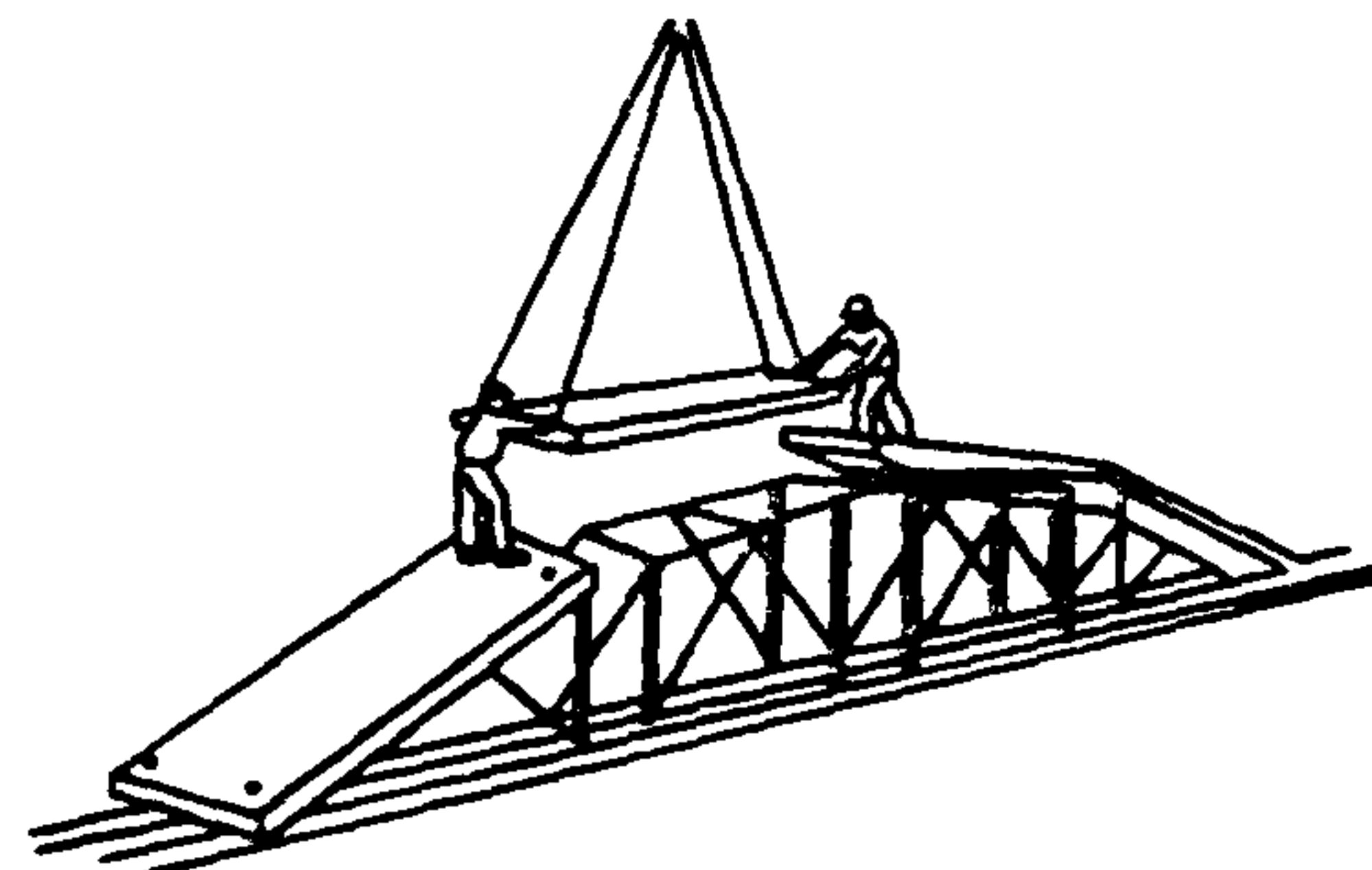
Монтажники  $M_3$  и  $M_4$  очищают места опирания плит и закладные детали от наплынов раствора, стропят и подают плиты на кондуктор, раскладывают затяжки и подвесы. Монтажники  $M_1$  и  $M_2$  принимают плиты и укладывают их на кондуктор. Положение уложенных на кондукторе плит выверяют метром. При необходимости монтажники  $M_1$  и  $M_2$  ломами рихтуют плиты в пределах нанесенных на кондукторе рисок и ограничителей
