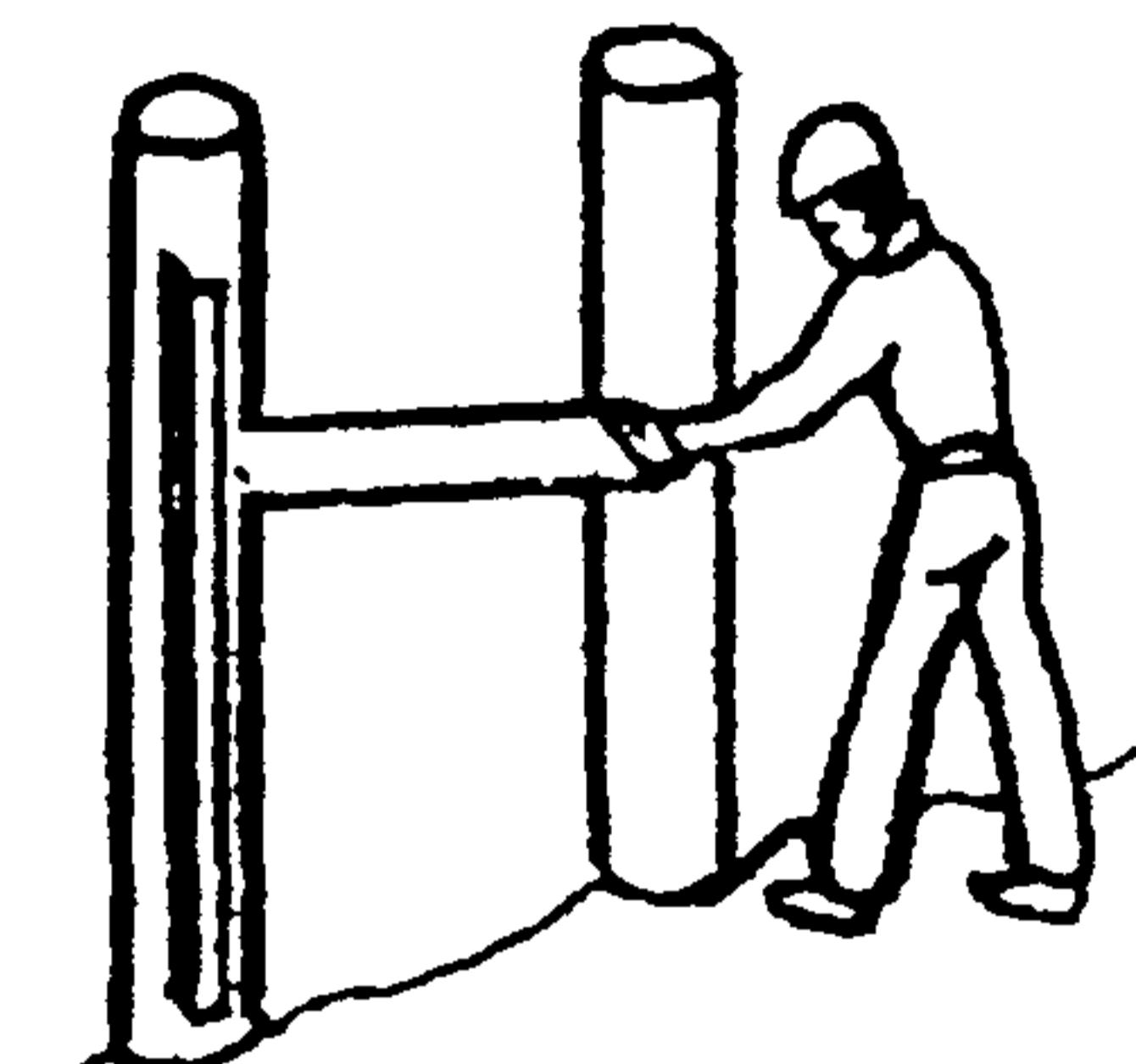
Плотник (П1) вставляет доску одним концом в паз между уголком и стальной трубой,
