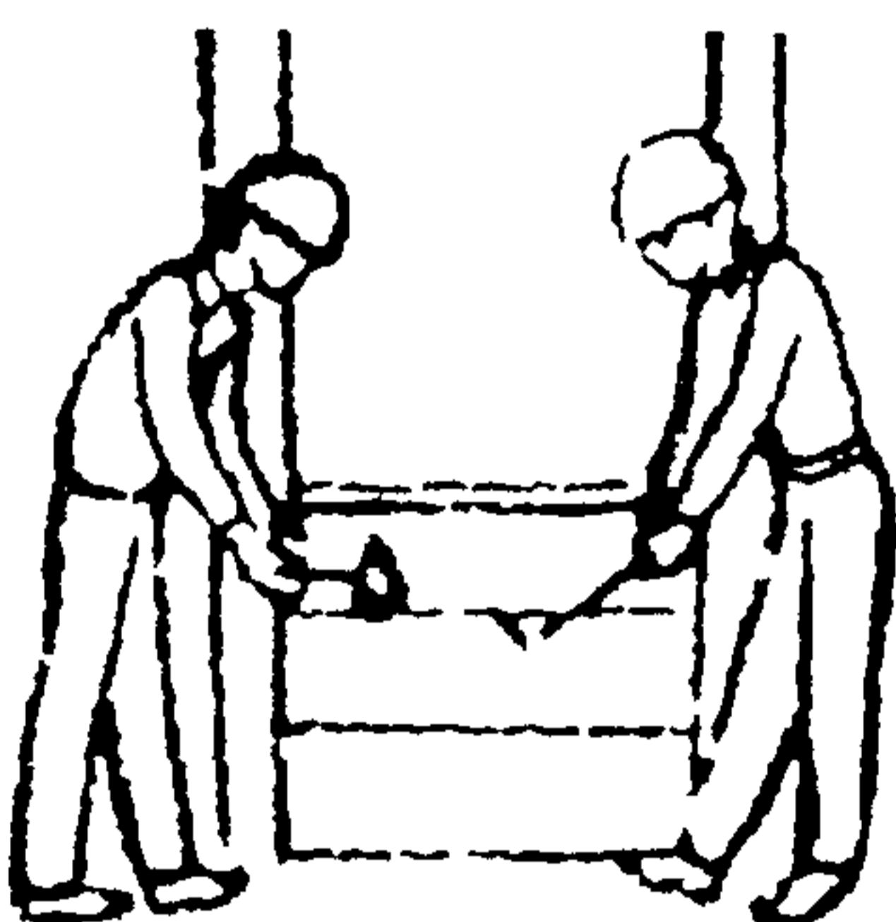
Плотники (П2) и (П3) молотком и монтажным ломом устанавливают доску в проектное положение.
