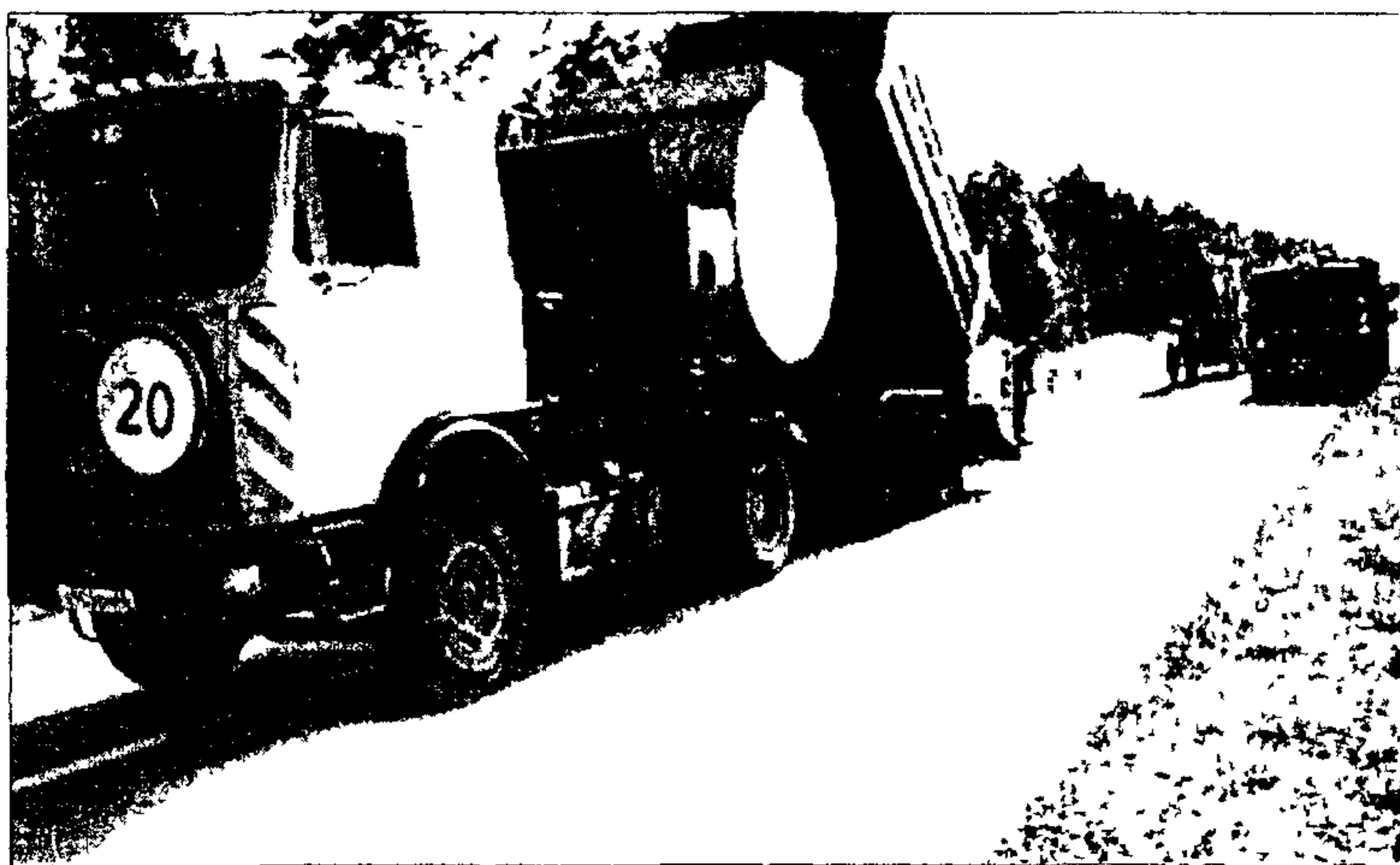
*Рис. 4.1. Устройство поверхности обработки машиной с синхронным распределением материалов типа «Чипсилер».*
