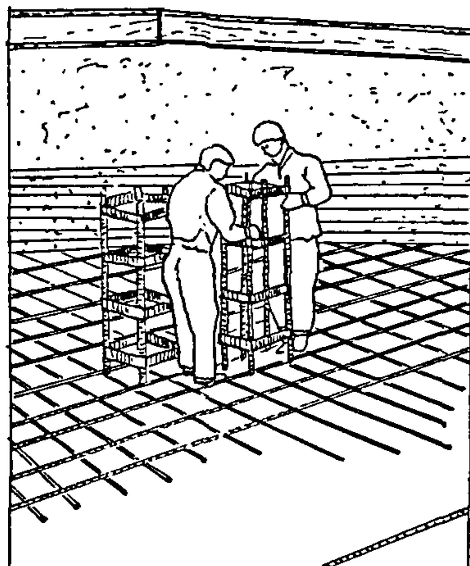
Рис. 5. Установка монтажных столиков
