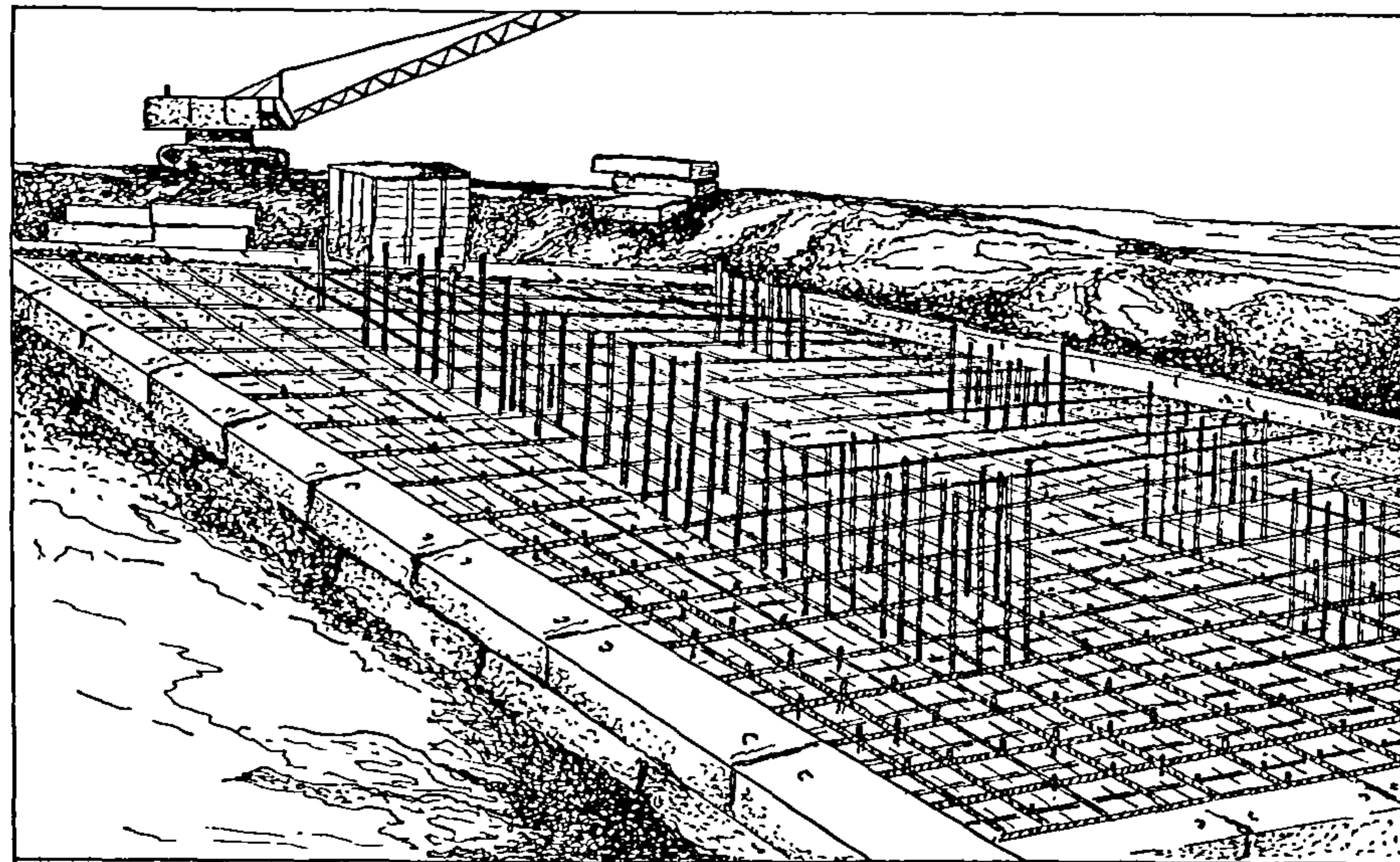
Рис. 3. Установка арматуры монолитной фундаментной плиты
