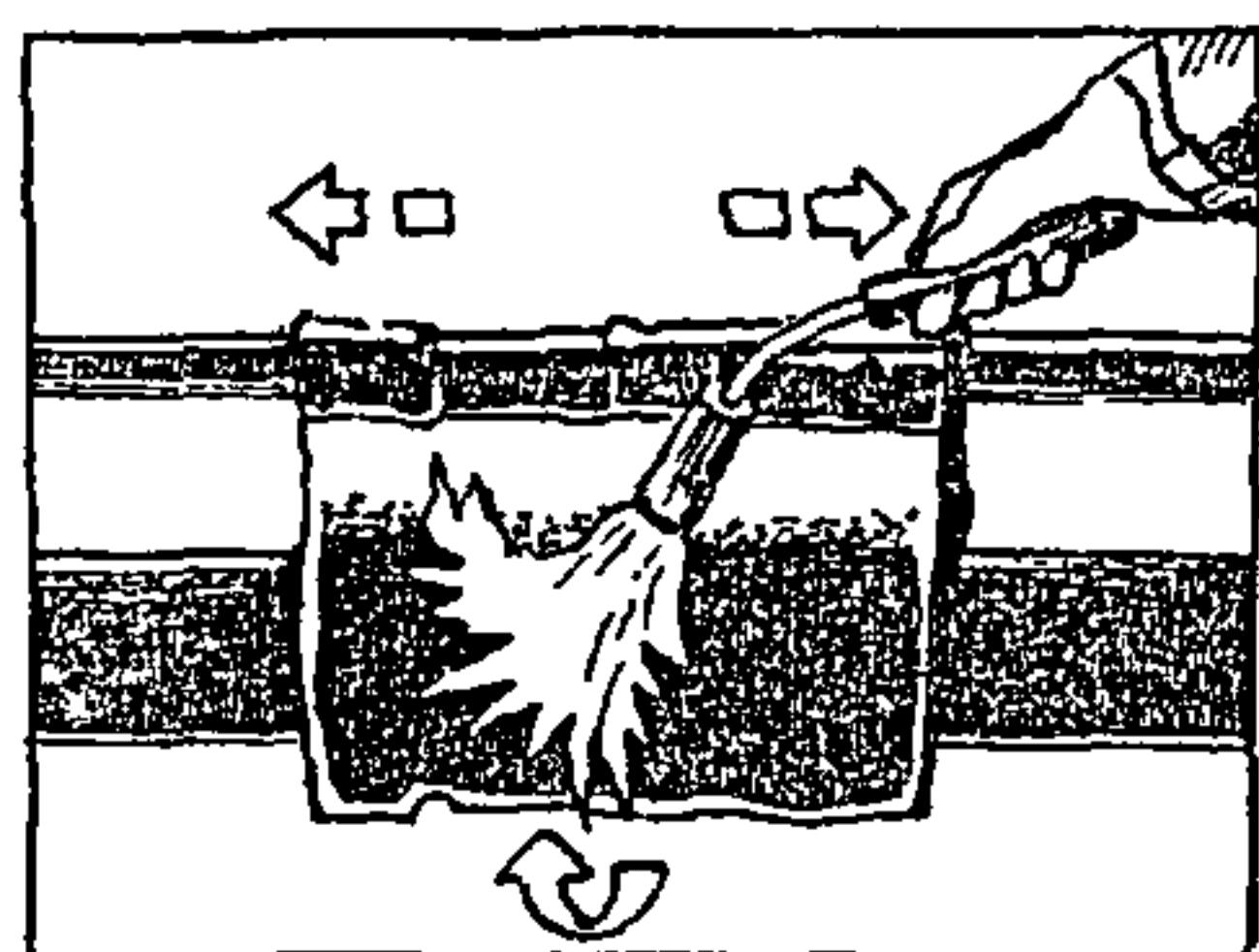
Рис.4. Прогрев манжеты мягким желтым пламенем горелки вкруговую, начиная от центра к краям до полной усадки
