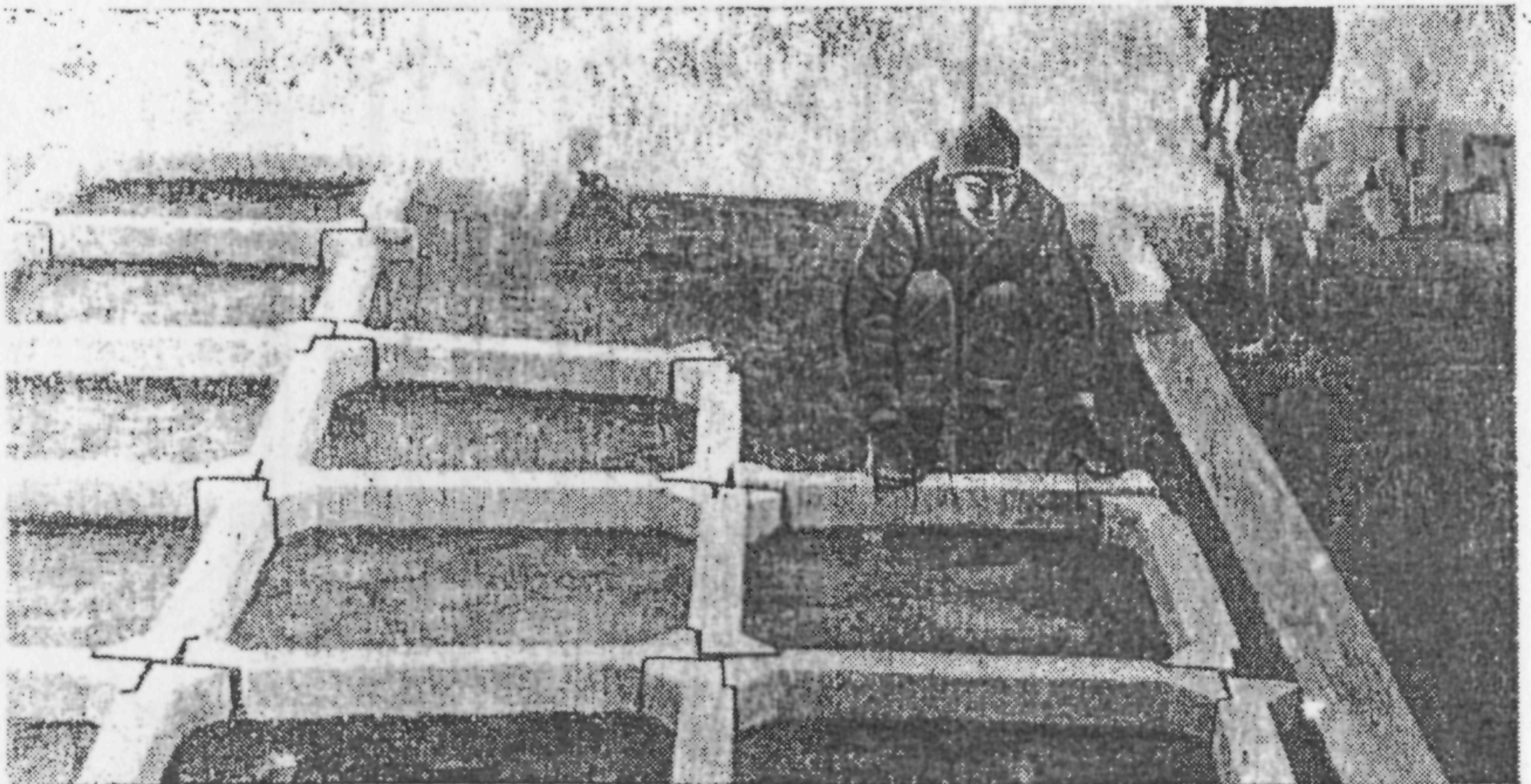
Рис. 9. Монтаж решетчатой конструкции при укреплении подтопляемых откосов на мостовом переходе через Синганайскую протоку (автомобильная дорога Нефтеюганск—Сургут, трест «Тюмендорстрой»)
